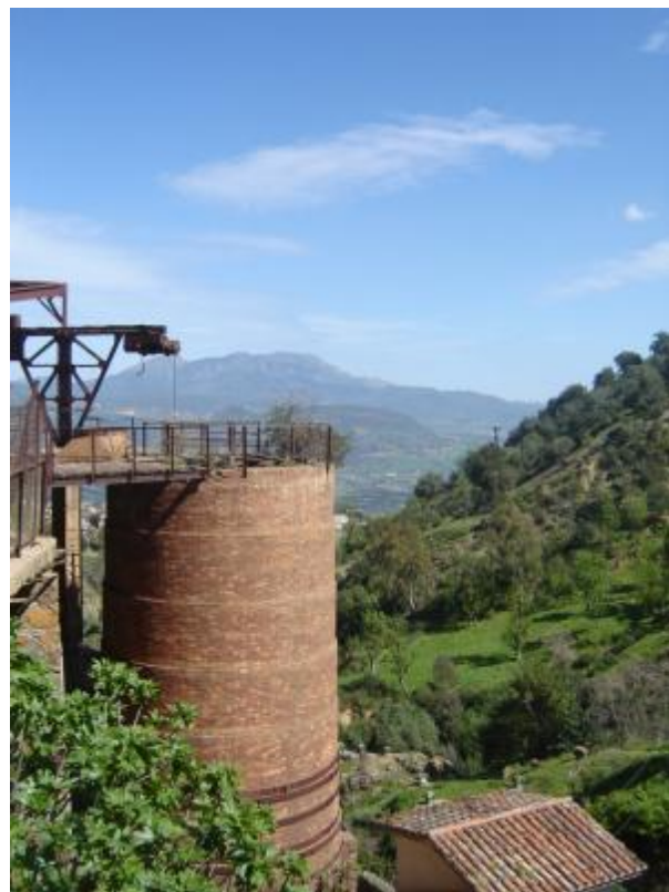
Photo 96 vu sur le four source : auteur
