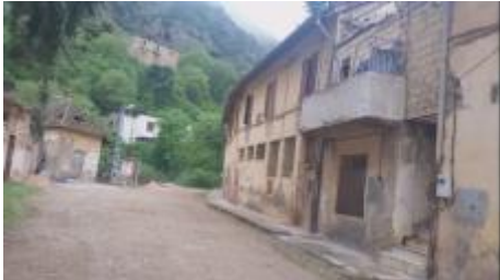
Photo 80 Mine de tmezrit vue générale
