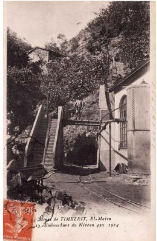
Photo 54 Mine de timezrit : 1914 embouchure de niveau 450
