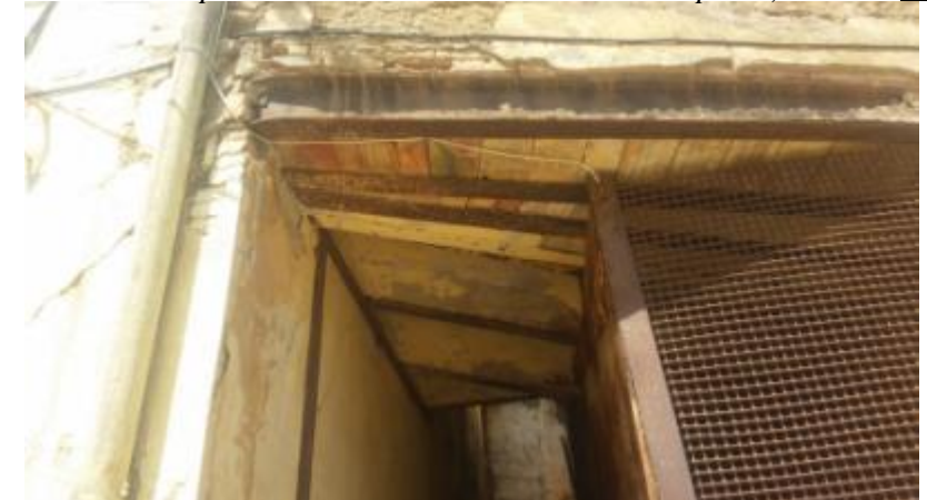
Photo63 les premières maisons des ouvrières européennes) plancher composé de poutres métalliques et des hourdis en pierres revêtu de roseau et une couche de plâtre
