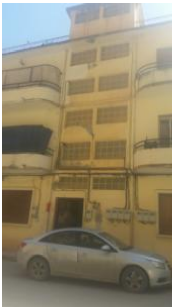
Photo 102 Traitement du volume de la cage d'escalier dans la façade
