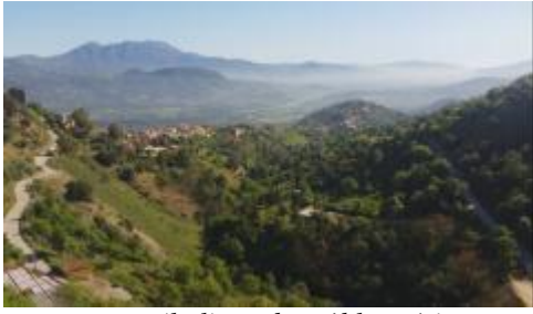
Photo 136 (la ligne des câbles aériens)
