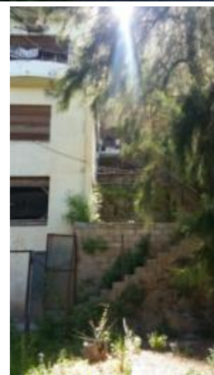
Photo 114 Dans ces deux photos, nous montrons l'escalier qui descend jusqu'à l'espace de jeu et la piscine
