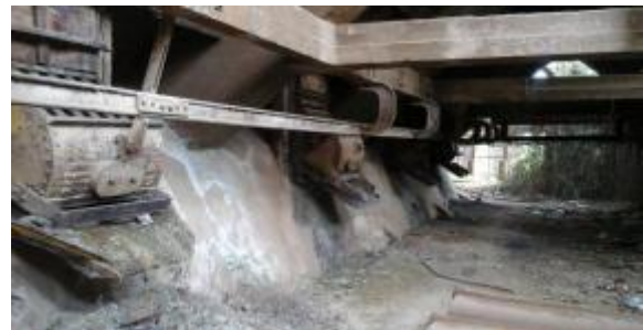
Photo 162 La trémie Source auteur.
