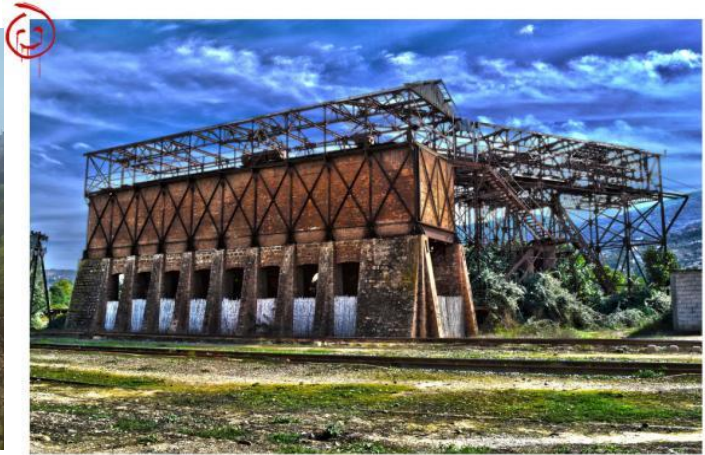
Photo 95 Vue sur la station au niveau de la gare ferroviaire de Timezrit Source : facebook.com
