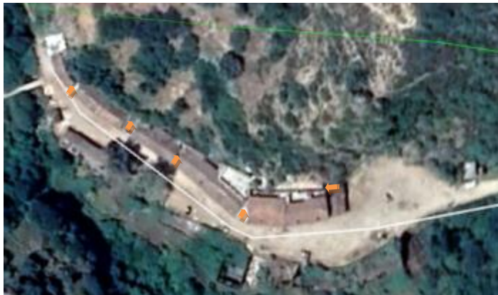
Photo6 9 Emplacement des cages d'escaliers source : Google earth +auteur
