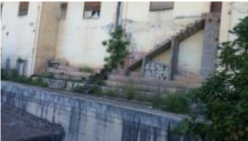
Photo 116 Vue sur les gradins de la piscine en béton armé
