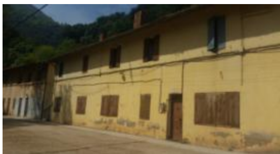
Photo 83 Bureaux des géomètres de la mine source : auteur
