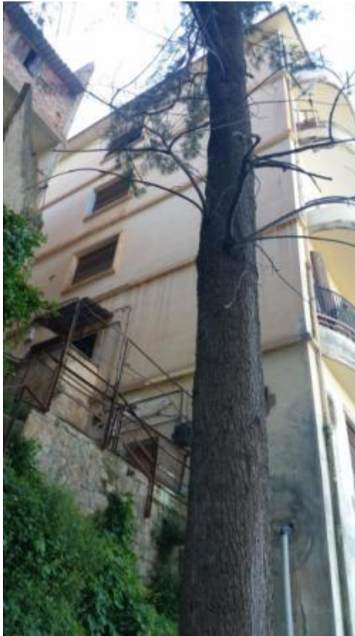
Photo 107 Vue sur la façade latérale et l'escalier qui desservi les étages en entresol et qui mène vers l'espace de jeu et la piscine
