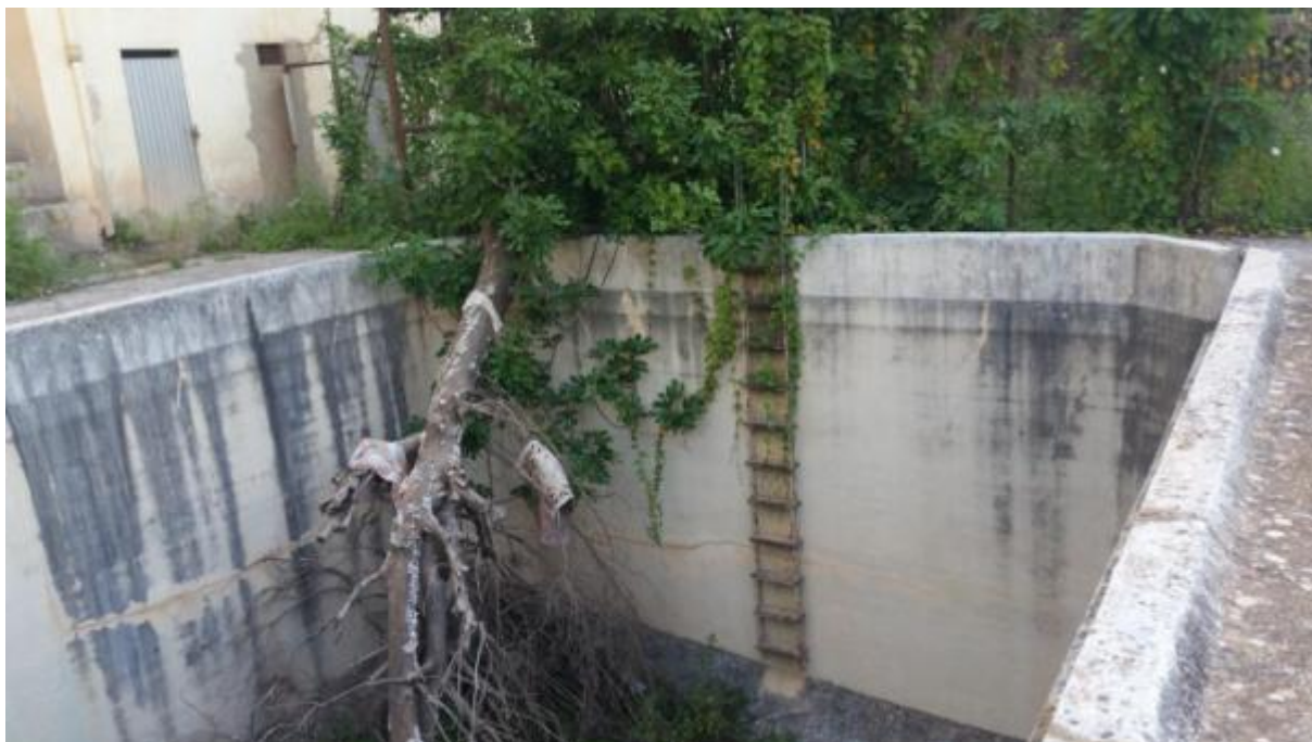
Photo 121 Echelle pour descendre et monter dans la partie profonde
