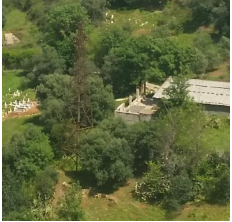
138 Zoom sur un pilier qui porte les câbles aériens
