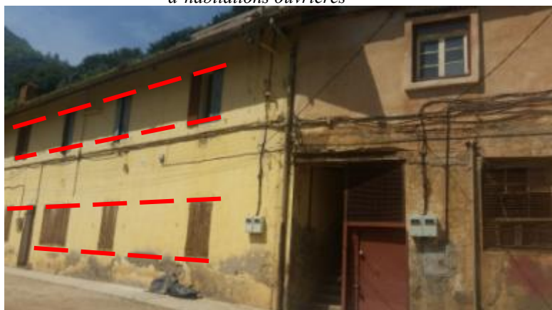
Photo71 Cage d'escalier et alignement des ouvertures dans les blocs d'habitations ouvrières source : auteur
