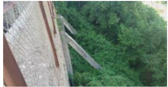
Photo 119 Vue sur la structure qui porte la piscine avec des appuis inclinés. (Plate forme surélevée du sol)
