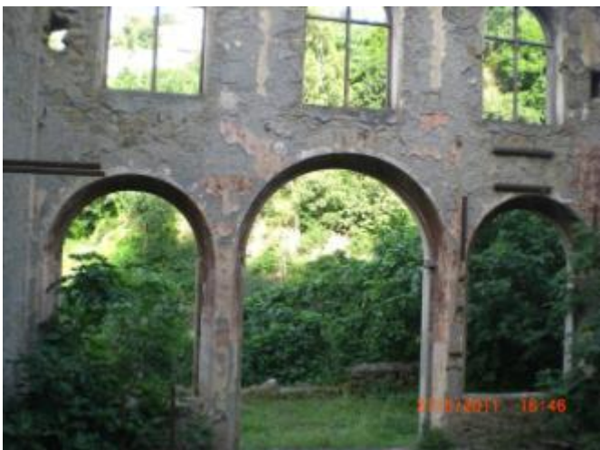
Photo 90 vue sur le compresseur
