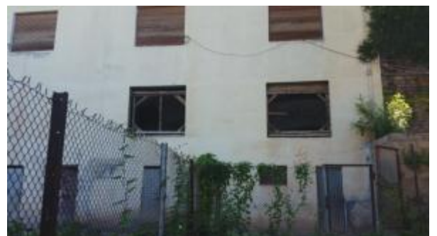
Photo 110 Vue sur la façade postérieure a partir de l'espace de jeu pour enfant
