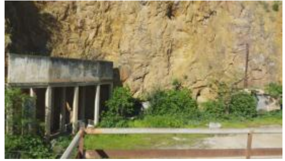
Photo 154 Bâche à eau ( source : auteur)
