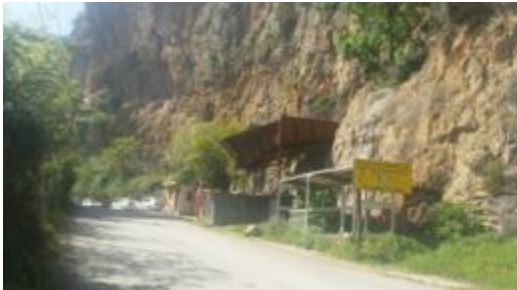
Photo 150 vue sur l'entrée de la mine source : auteur
