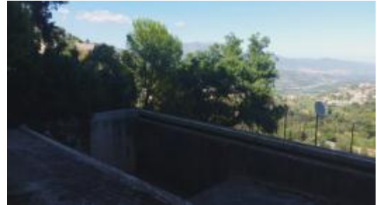
Photo 117 Vue sur la piscine en béton armé
