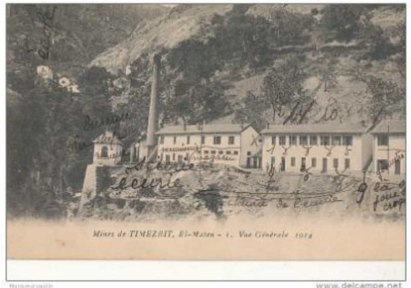
Photo 58 Mine de timezrit : vue generale (année 1914)
