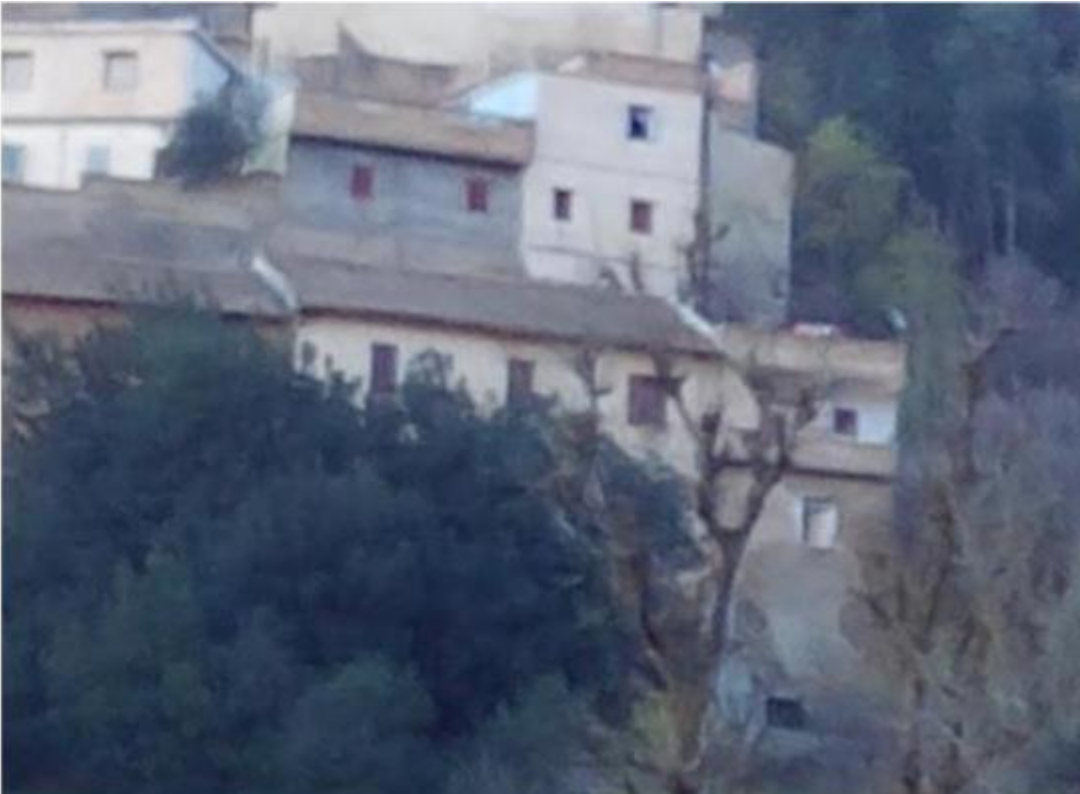
photo 88 vue sur l'ancienne maison du directeur « bordj n Dora » Construite vers 1904
