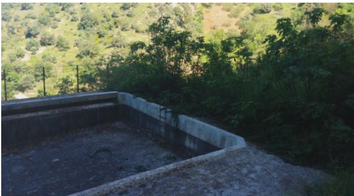
Photo 122 Echelle pour descendre et monter dans la partie moins profonde
