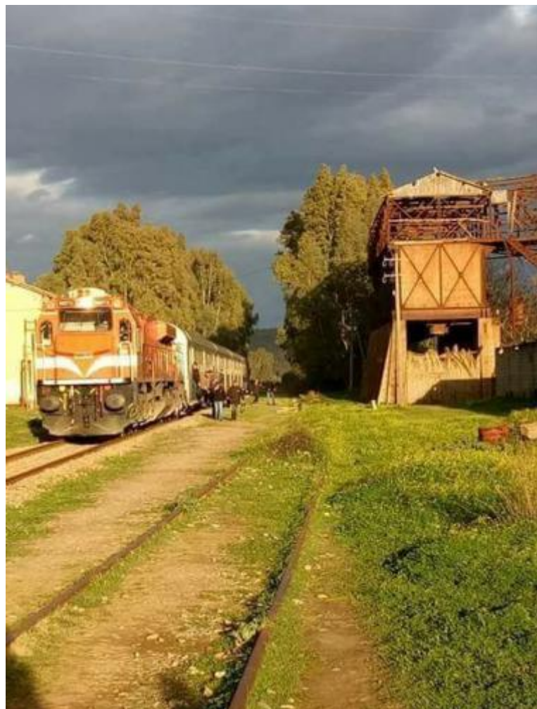
La gare de (Timezrit) avec la station du telepheric de la mine
