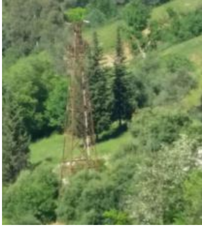
137 (la ligne des câbles aériens)
