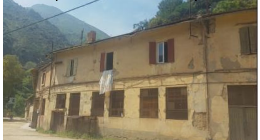
Photo62 les premières maisons des ouvrières européennes) Source : auteur
