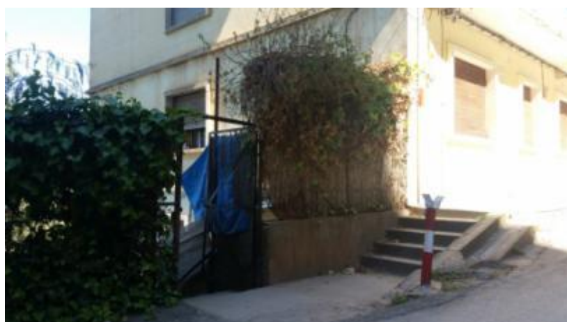
Photo 113 Dans ces deux photos , nous montrons l'escalier qui descend jusqu'à l'espace de jeu et la piscine
