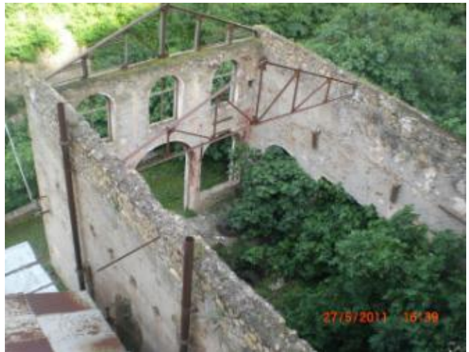
photo 91 vue sur le compresseur
