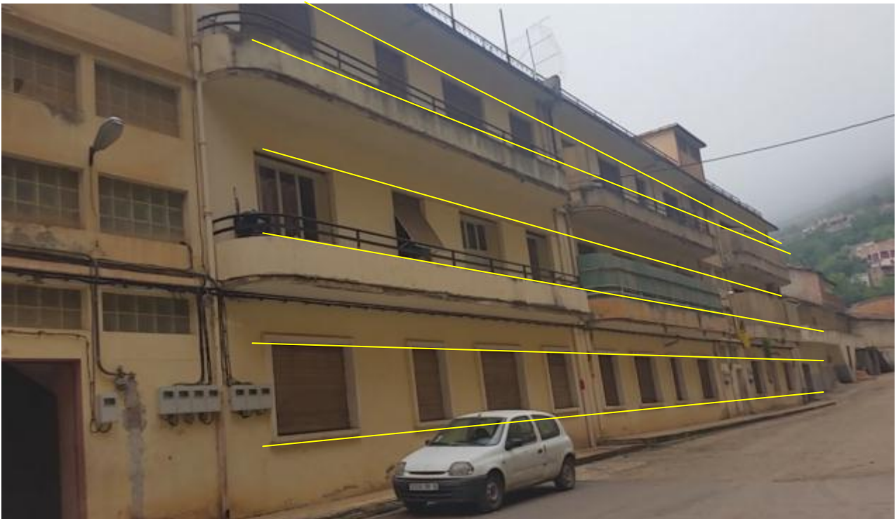
Photo 101 Alignement des ouvertures dans la façade principale
