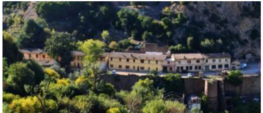
Photo60 vue générale l'ex maison du directeur Source : auteur
