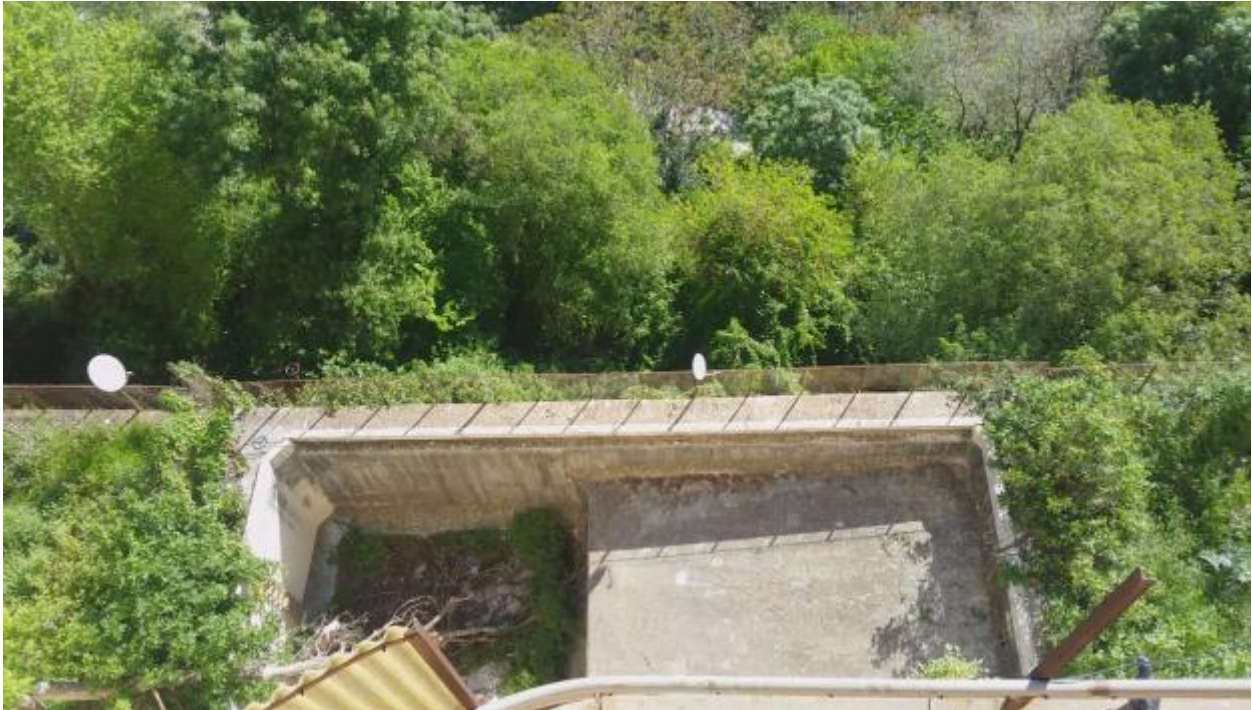
Photo 115 Vue sur les gradins de la piscine en béton armé
