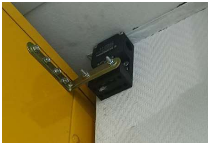
FIGURE 3.3 – Système de la porte indiquée que la porte est fermée
