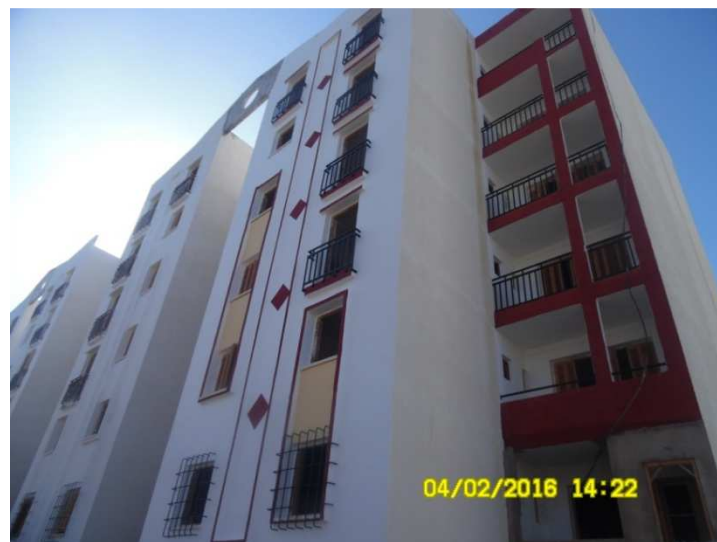
Fig.III .9 : Façade principale du bloc existant
