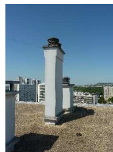
C-cheminée de conduit « Shunt » sur terrasse
