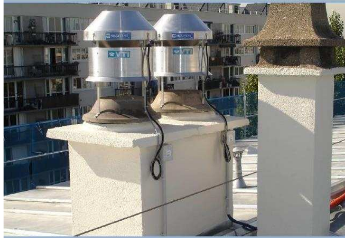
Fig.II.13: Ventilation mécanique contrôlée simple flux hygroréglables.
