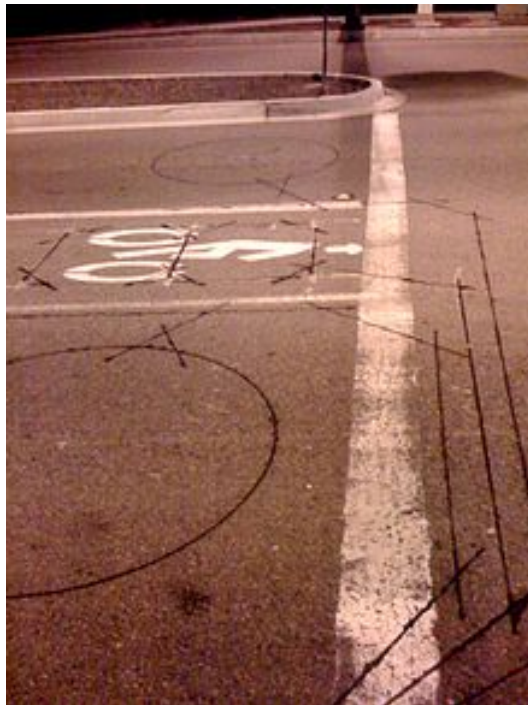
FIGURE 4.1: Boucles d'induction magnétiques
