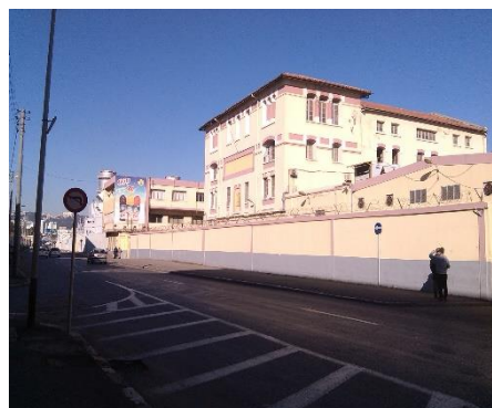
Figure 23 : Rue Hassiba Source : auteurs
