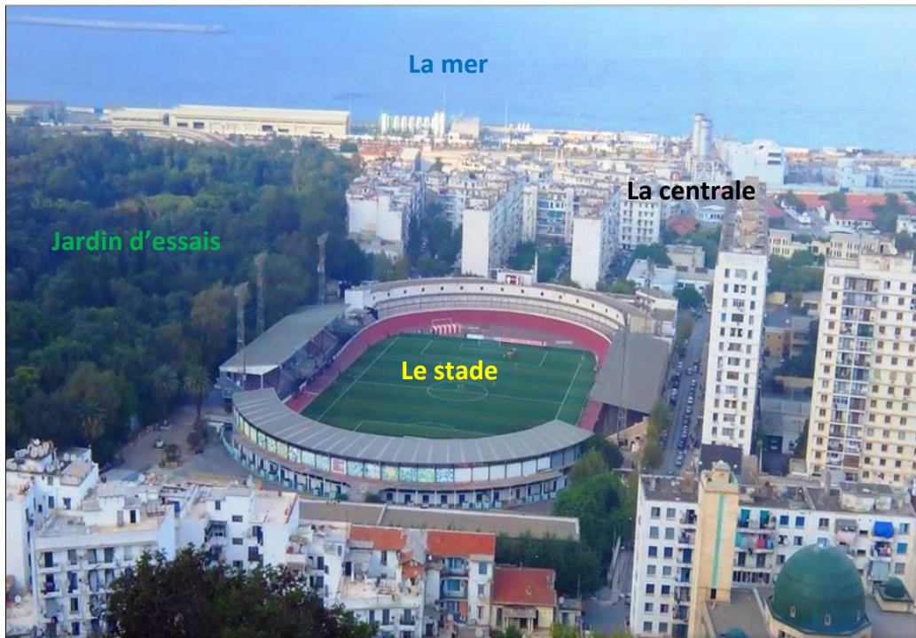
Figure 21: Vue d'ensemble sur le quartier Source : Google Earth/Auteurs
