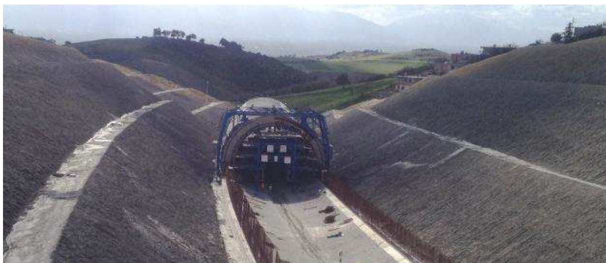
FIGURE II.1. Ouvrage construit dans une fouille talutée.
