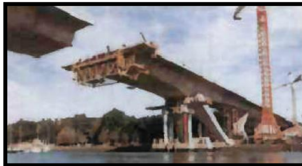
Figure I.7 : Construction à béquilles d'Auray.
