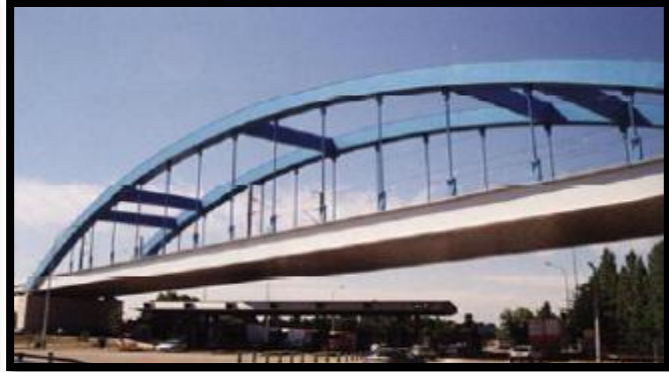
Figure 9 : Pont en arc à tablier inférieur.
