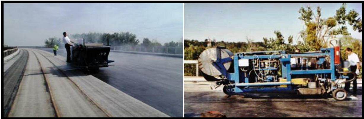
Figure X.17 : Revêtement du tablier.
