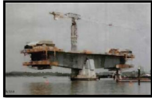
Figure I.6 : Voussoir coulés sur place.
