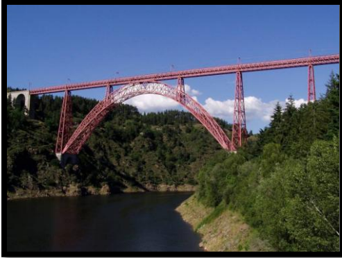
Figure 8 : Pont en arc à tablier supérieur.
