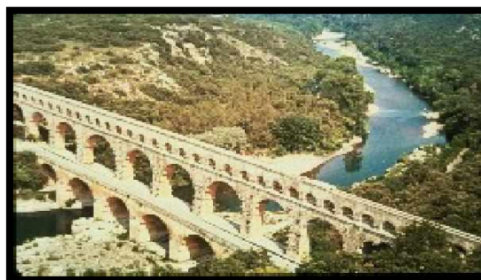
Figure 1 : Pont en maçonnerie (pont du Gard).
