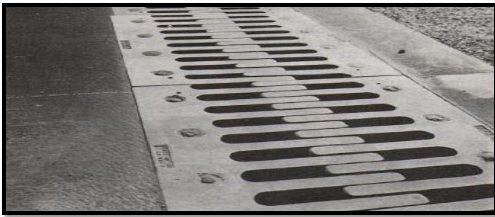
Figure X.13 : Joint de chaussée.
