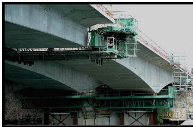
Figure I.8 : Voussoir coulé en place.
