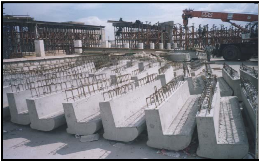
Figure X.18 : Corniches préfabriquées sur chantier.
