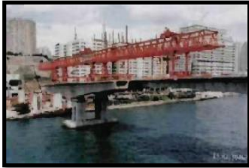
Figure I.5 : Voussoirs préfabriqués.
