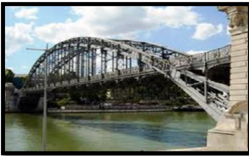
Figure 10 : Pont en arc à tablier intermédiaire.
