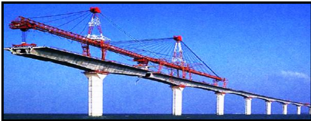
Figure 7 : Ponts à caissons.
