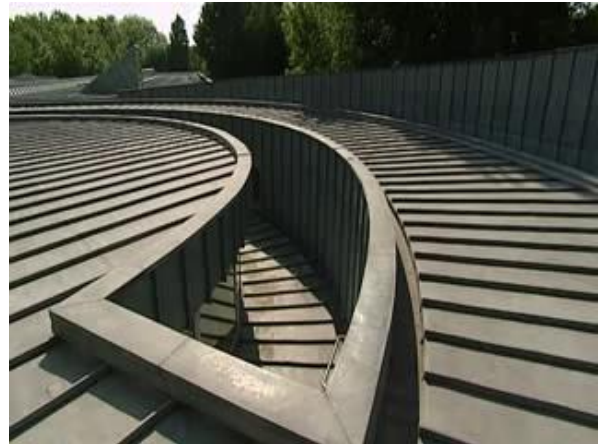
Photo II-48 : Faille d'éclairage de la salle d'exposition.
