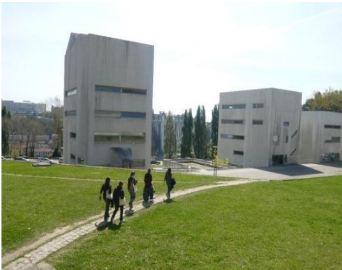
Photo II-42 : Vue sur les quatre cours de l'école. Source : spain.aricaustermann.com
