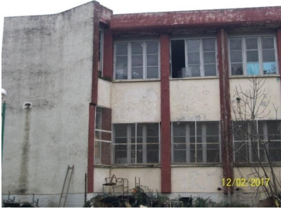
Photo III-81 : Façade Nord du bloc B. Source : Auteurs.
