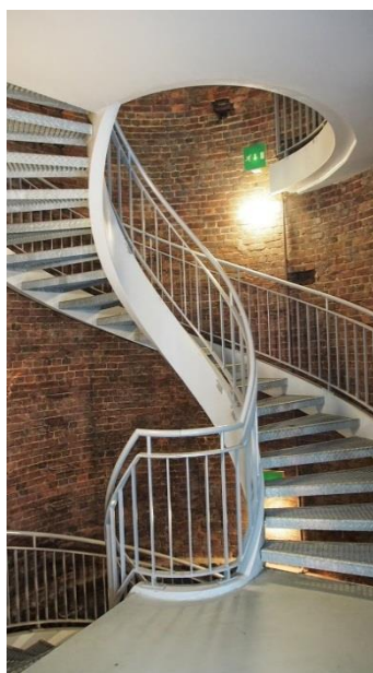
Photo II-8 : Intérieur de la cheminée du la SUDAC après sa réhabilitation.
