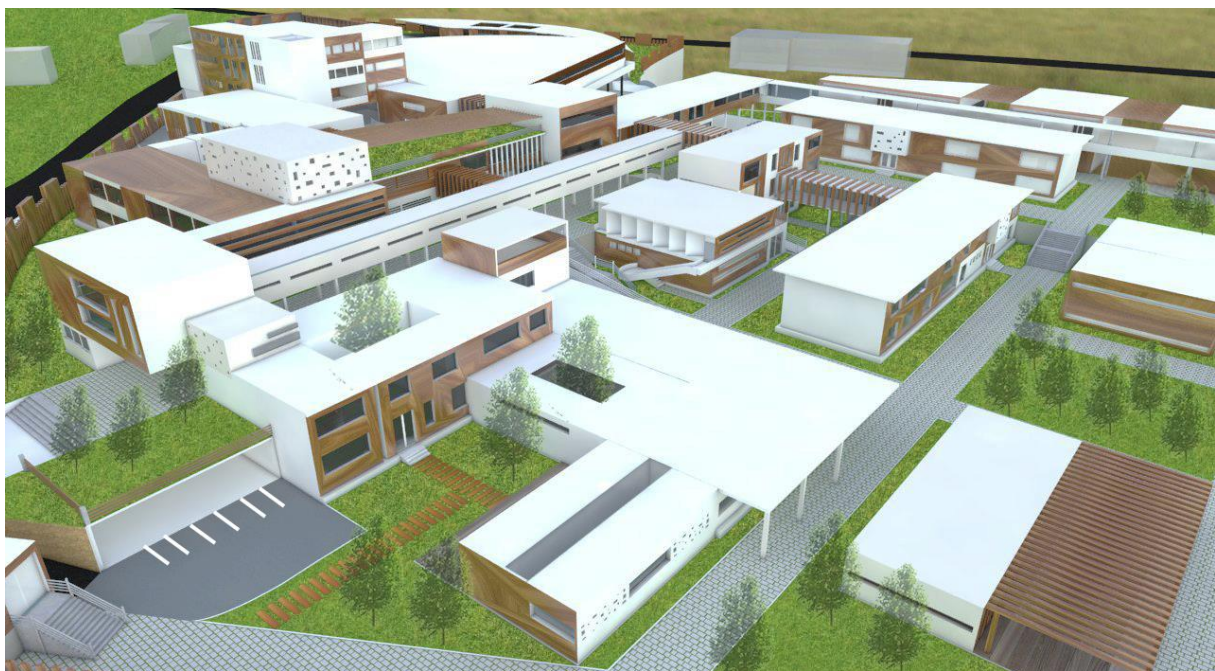
Figure IV-72 : Vue sur l'ensemble des façades du projet Source : Auteurs
