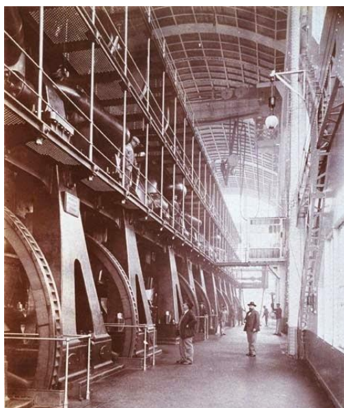
Photos II-2 : usine du quai de la gare Source : lafabriquedeparis.blogspot.com
