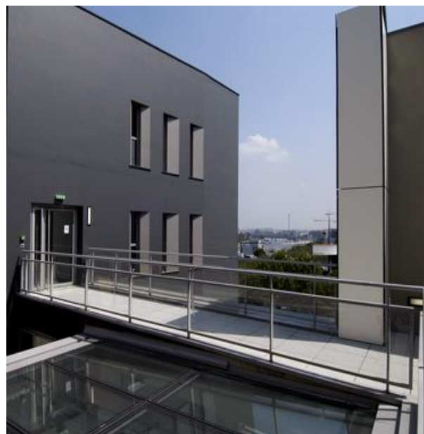
Photo II-25 : Vue sur la passerelle du 7eme étage.
