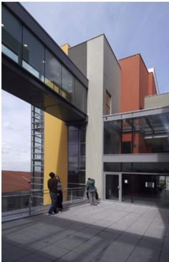
Photo II-22 : Vue sur la terrasse du 5eme étage.
