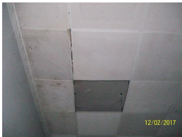
Photo III-86 : Vue sur le faux plafond de l'amphithéâtre.
