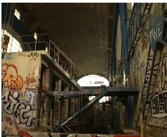
Photo II-16 : Intérieur de la halle avant la sa réhabilitation Source : www.youtube.fr
