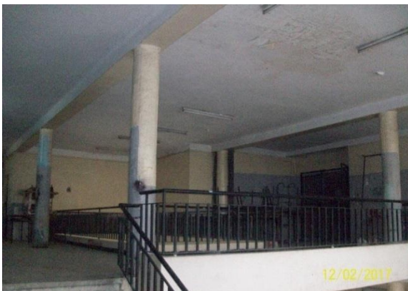
Photo III-83 : Structure apparente de la mezzanine. Source : Auteurs.
