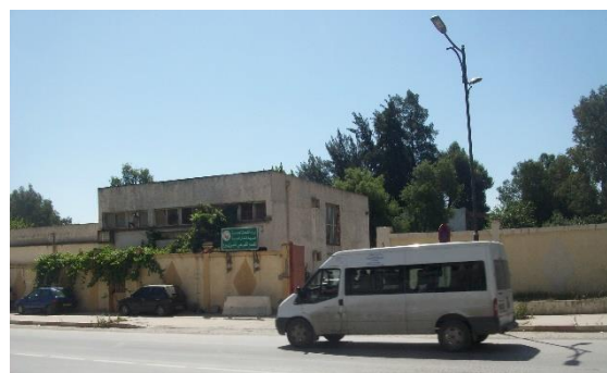
Photo III-63: Unité de travaux publiques
