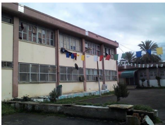
Photo III-71: Vue sur les blocs résidentiels. Source : auteurs.
