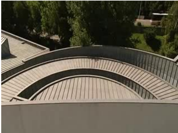
Photo II-47 : Faille d'éclairage de la salle d'exposition.
