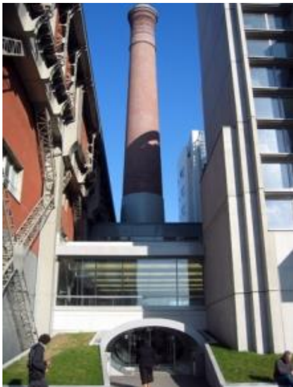
Photo II-36 : entrée principale de l'école.
