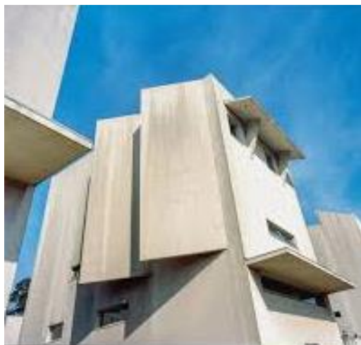
Photo II-43 : vue sur les brises soleil des tours.
