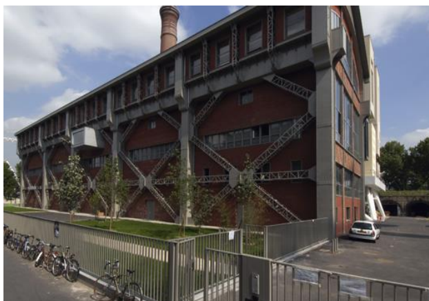
Photo II-11 : Vue sur la halle après sa réhabilitation Source : www.paris-valdeseine.archi.fr
