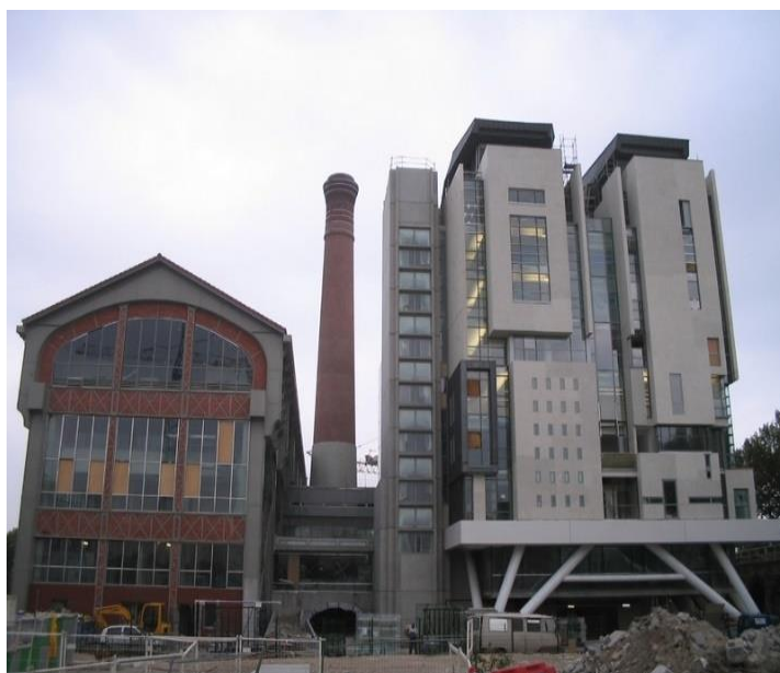
Photo II-21 : Vue sur la façade principale. Source : www.fredericborel.fr
