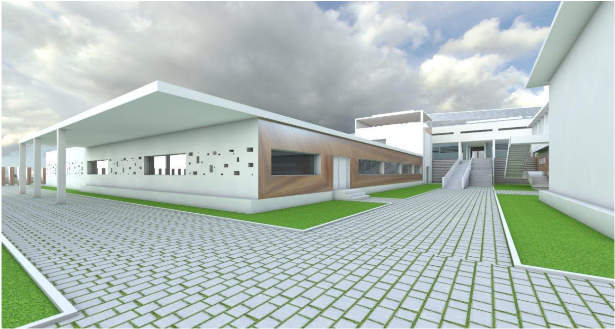
Figure IV-71 : Vue sur la façade réhabilitée du réfectoire Source : Auteurs
