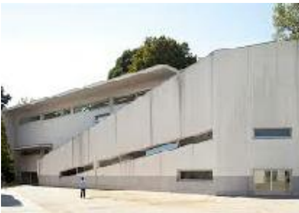
Photo II-55 : vue sur la rampe de l'extérieur
