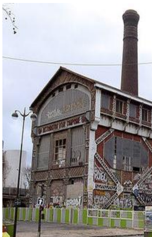
Photo II-14 : Façade originelle Source : www.paris-valdeseine.archi.fr
