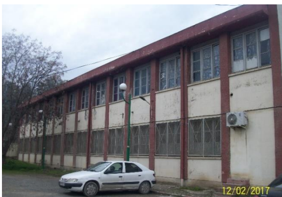
Photo III-79 : Façade Sud-Ouest du bloc A. Source : Auteurs.
