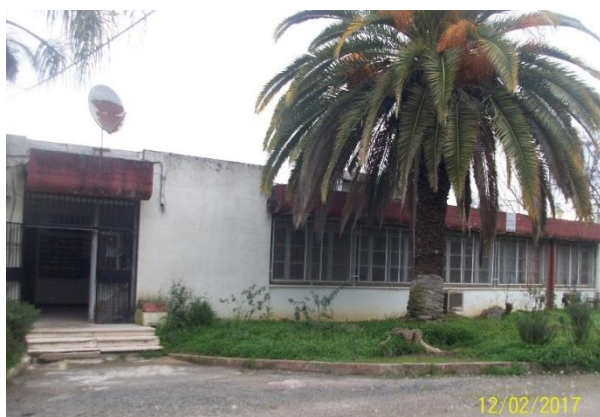
Photo III-87 : façade du bloc administratif
