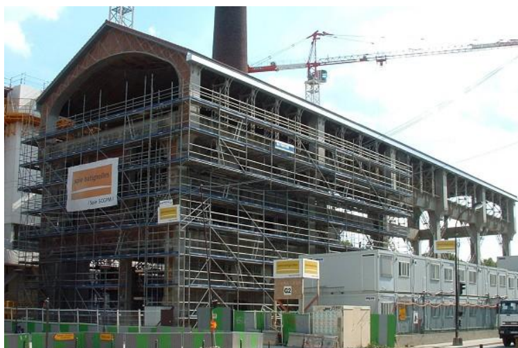
Photo II-10 : Chantier de réhabilitation de la halle Source : www.structurae.info
