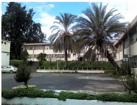
Photo III-72 : Vue sur les blocs résidentiels. Source : auteurs.
