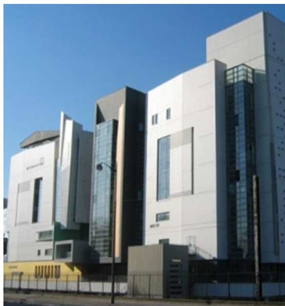
Photo II-24 : Vue sur la façade depuis le quai.
