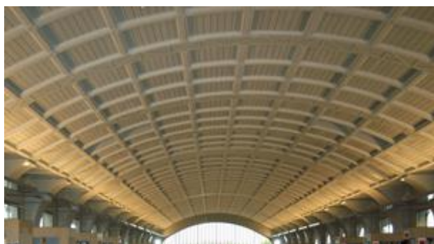
Photo II-6 : La charpente réparée de la halle Source : www.brudieuxfranck.com
