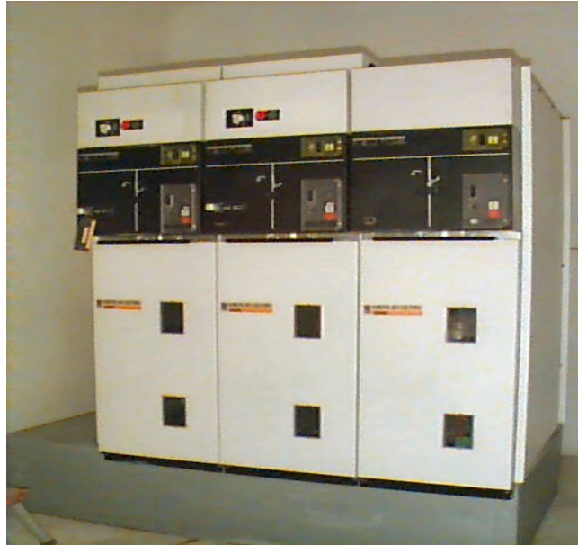
Figure 1.4: Cellules d'un poste HTA/BT
