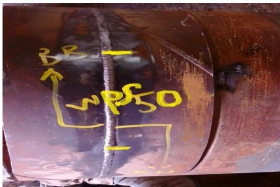
Figure 3.8: Nettoyage par brossage et repérage de cordon de soudure.
