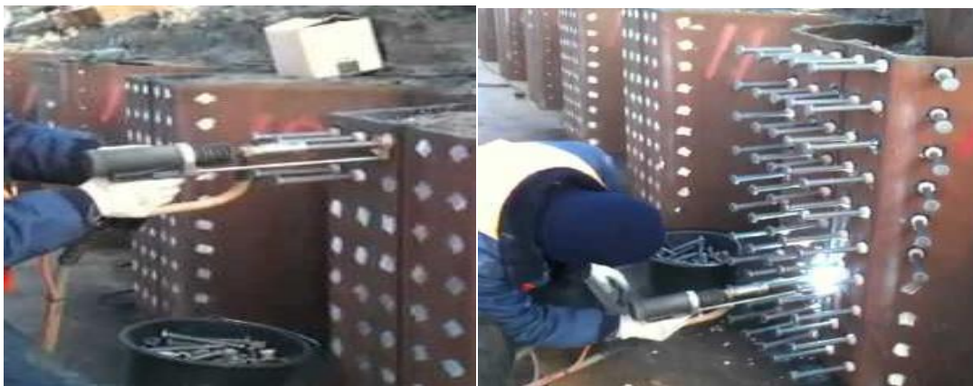
Figure 9.3 : Soudage des goujons.
