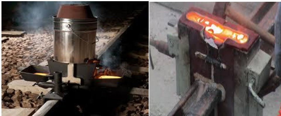
Figure 9.6 : Soudage aluminothermique.
