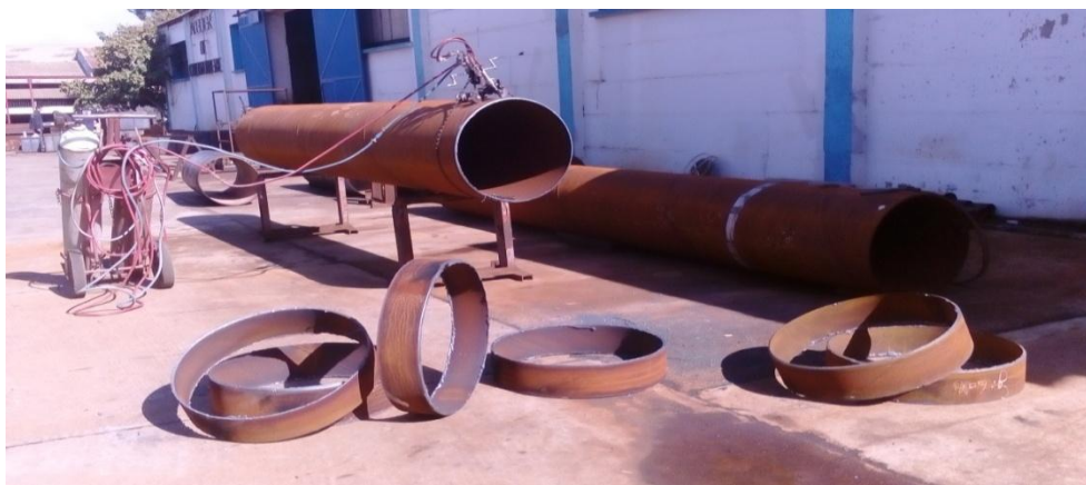
Figure 3.2 : Débitage des échantillons avec la chanfreineuse manuel à oxycoupage.
