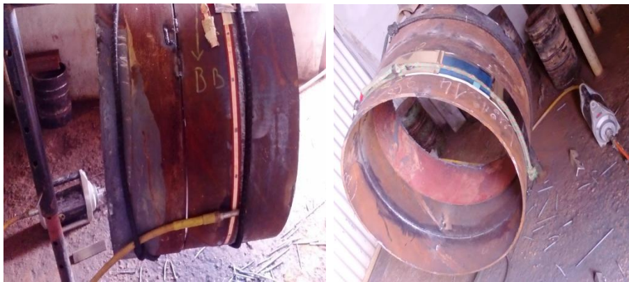
Figure 3.19: Inspection par gammagraphie de l'éprouvette de réparation.
