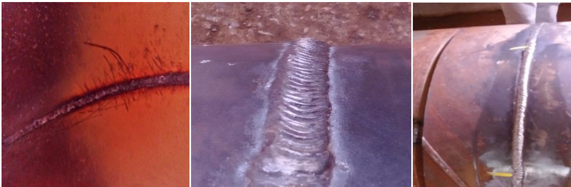
Figure 3.18: Défaut de dénivèlement tolérable et réparation.
