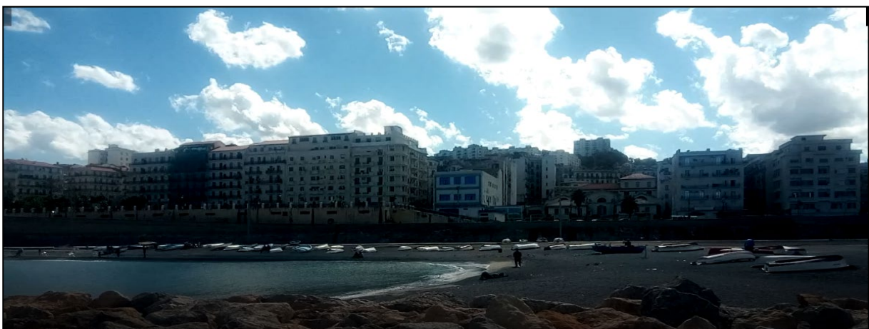
Figure 122: vue sur le parcours de front de mer.
