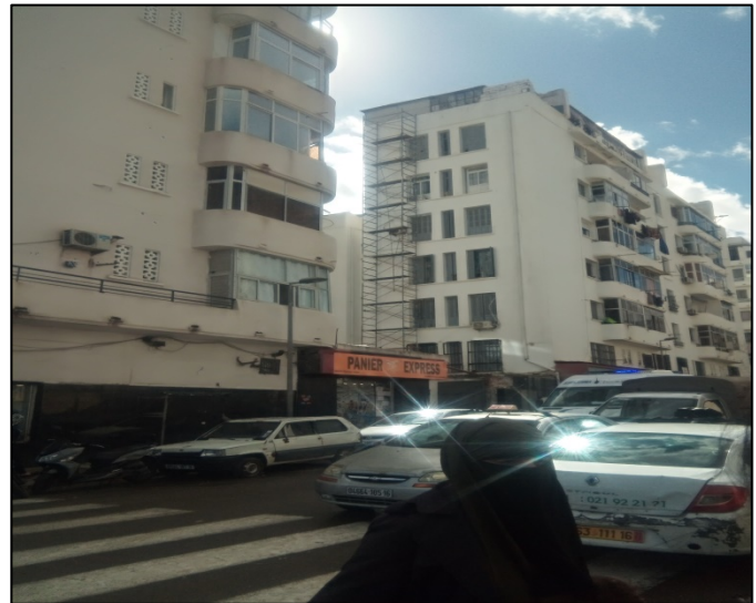
Figure 101: les HBM de BEO. Source : photo prise par l'auteur.
