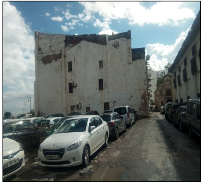
Figure 100: l'état de bâti de la cité Bugeaud. Source : photo prise par l'auteur.
