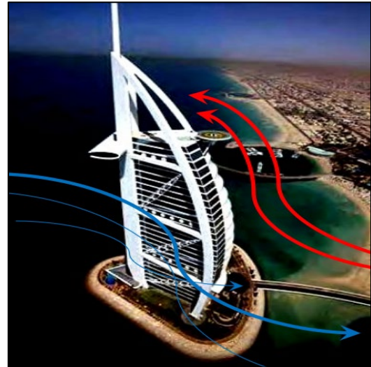
Figure 29 : impacte du vent sur la tour bordj-el-arabe.
