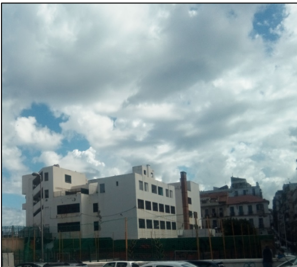
Figure 58: Le style moderne à l'Ecole rue de djon de BEO. Source : photo prise par auteur.
