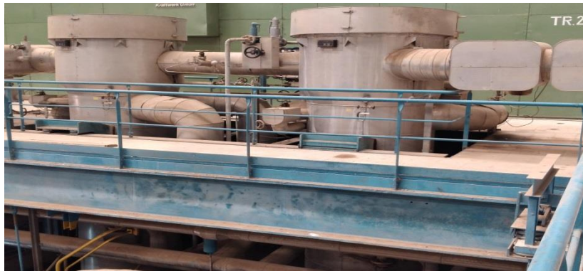
Figure I.13 : réchauffeur HP
