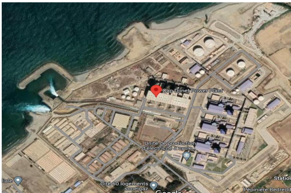
Figure I.1 : vue prise par google earth pour la centrale de Cap-Djinet[2]
