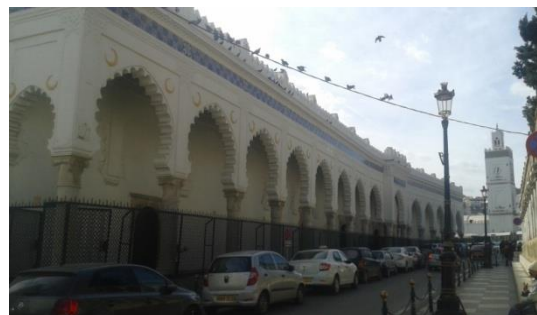
Fig.90 Réhabilitation du Djamaa EL Kebir
