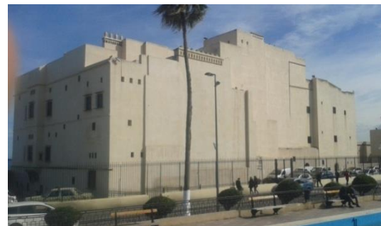
Fig.92 Réhabilitation du bastion 23
