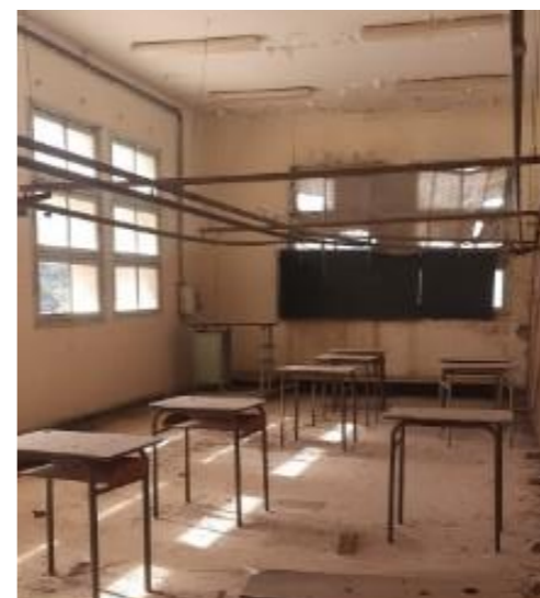
Photo 12 - aménagement d'une salle de cour
