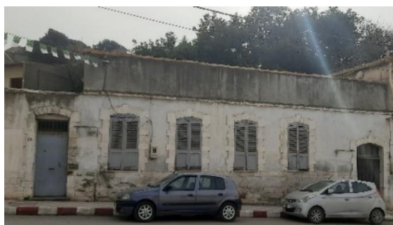
Photo 17 : Bâtiment colonial sobre - Source : auteur
