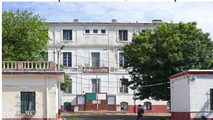
Photo 42 : Image du bloc 1 avant la restauration – Source : Site De fort national à Larbaa-Nath-Irathen
