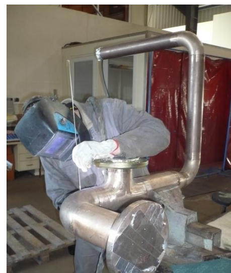
Photo 60: Travail de tuyauterie en atelier
