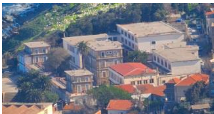
Photo 37: vue d'ensemble du lycée aujourd'hui
