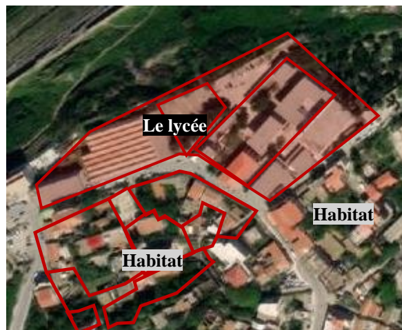
Figure 13 : Image aérienne de la 2eme section Source : Google Earth traité par auteur
