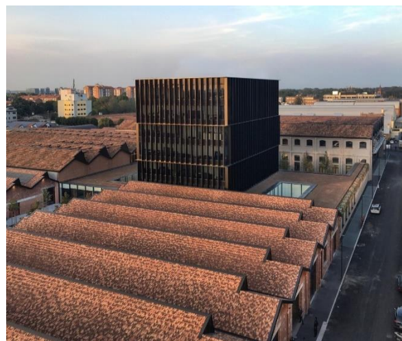
Photo 54: Extension contemporaine ajoutée Source: Arch Daily
