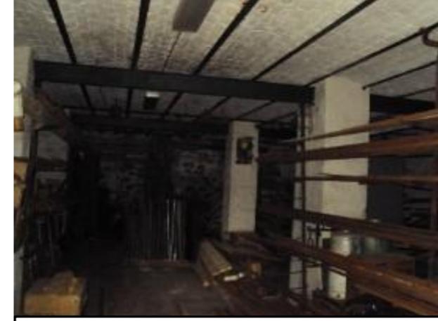
Photo 3 - sous sol de l'atelier
