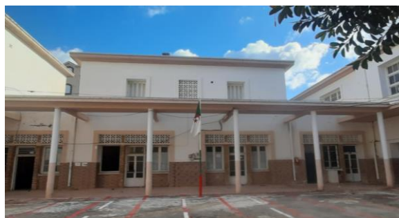
Photo 40 : Image du bloc 6 – Source : Auteur
