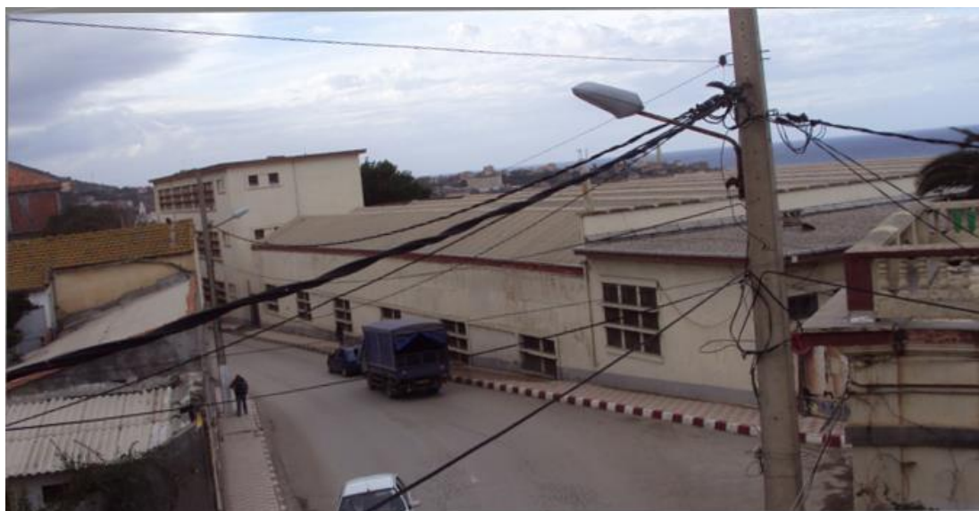
Photo 43 : Vue des ateliers depuis la rue 6 Source : BET Handassa Oua Bina
