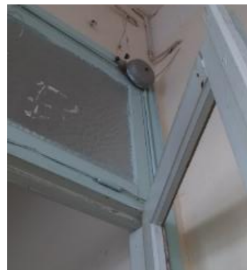
Photo 11 - porte d'entrée à l'étage
