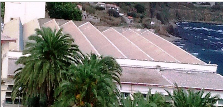
Photo 31: Vue en hauteur de l'atelier mécanique et sa toiture en sheds Source : fichiers photographiques transmis par le BET Handassa Oua Bina
