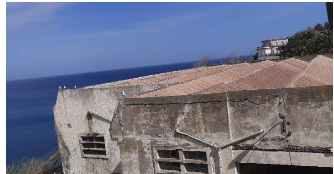
Photo 30: vue de l'atelier mécanique depuis le bloc 1 Source : Auteur
