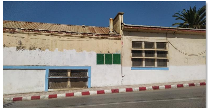
Photo 32: Vue de l'atelier depuis la rue Mabout Source Auteur
