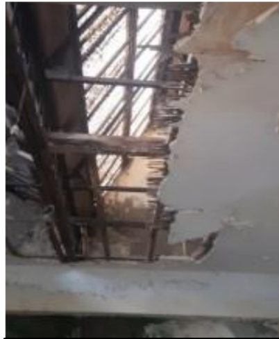
Photo 6 - Faux plafond salle de cour
