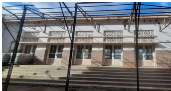
Photo 39 : bloc 8 en travaux – Source : Auteur
