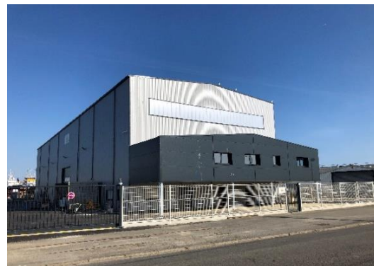
Photo 58: Hangars de l'atelier AML
