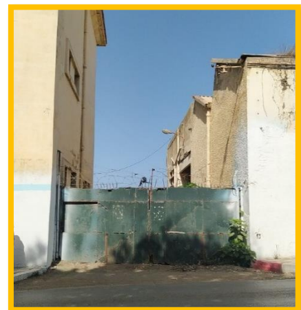
Photo 27: Entrée secondaire aux ateliers Source : auteur
