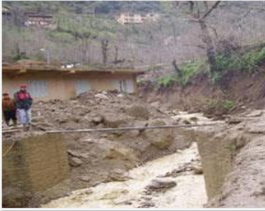
Fig. III.24 Pont dit Bouchiker emporté par la coulée boueuse.
