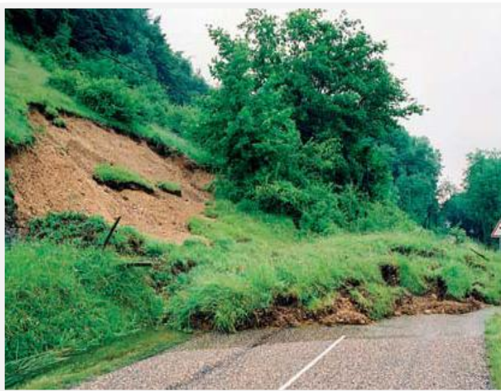
Fig. I. 14 Glissement de terrain ( GOMINET S, juin 2005 ).
