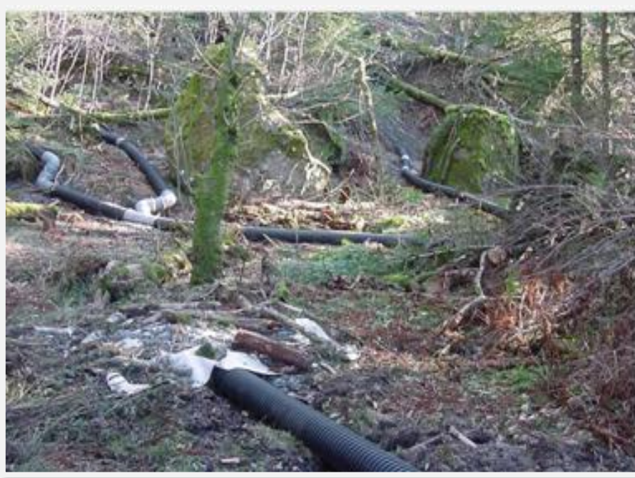
Fig. II.3 Parades contre les coulées de boue : réseau de captages et de drainages ( CHAHINE M. et RESTITUITO J, 2006 ).
