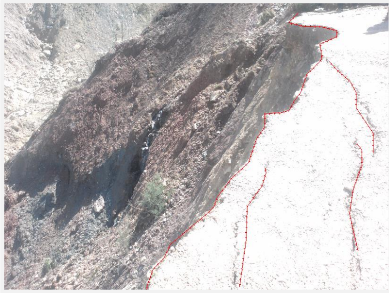
Fig. III.26 Route fissurée.
