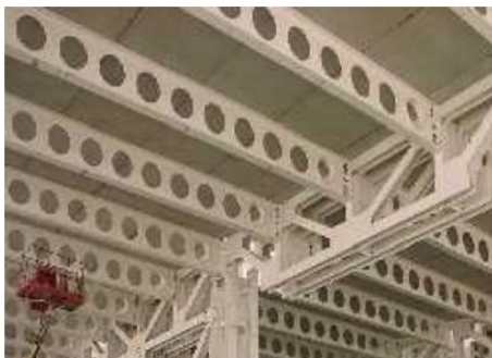
Figure : poutre alvéolaire.
