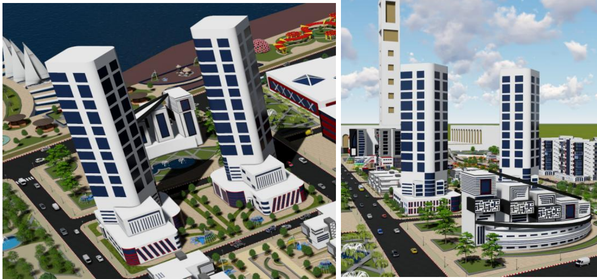
Figure101 : vues sur les deux tours d'affaires. Source : les auteurs.
