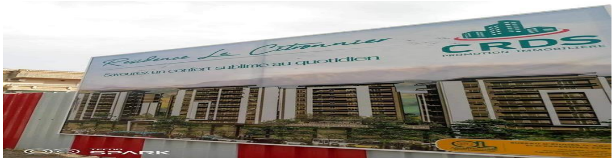
Figure 55 : Photo d'habitat collectif en cours de réalisation Source : Auteurs Date : 21-10-2024
