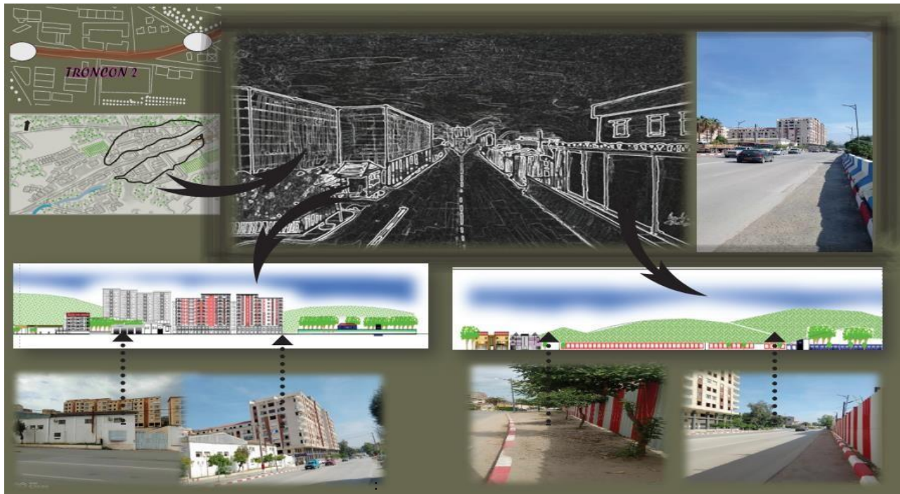
Figure 44 : Les parois du deuxième tronçon Source : Auteurs Photos :21-10-2024
