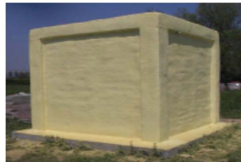
(b) Cabine avec isolation en polyuréthane
