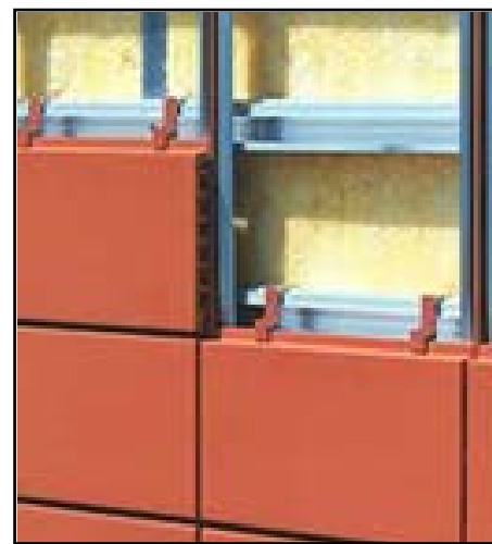
Figure 184 : photo de la mise en œuvre du bardage
