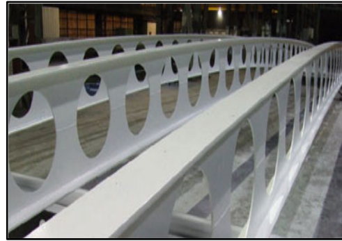
Figure146 : les poutres alvéolées
