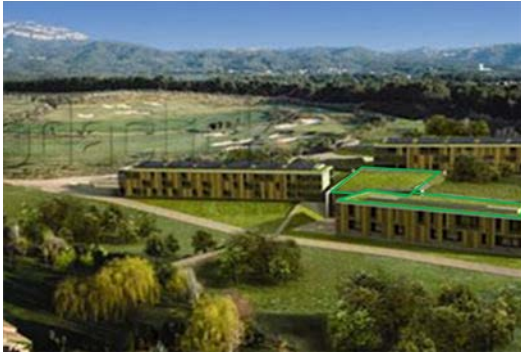
Figure 84 : les toitures végétales.
