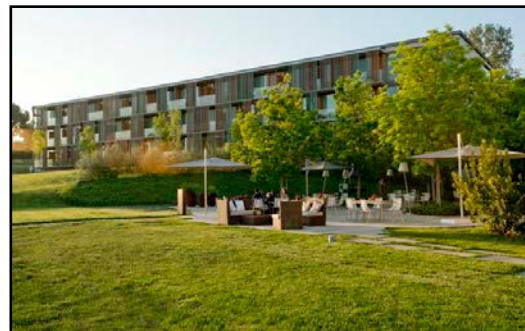
Figure83 : façade sud, mur rideau avec stores colorés.
