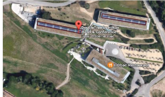
Figure81 : les panneaux photovoltaïques dans la Mola hôtel
