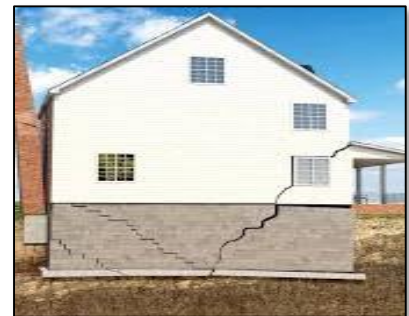
Figure I - 5 : Tassement différentiel
