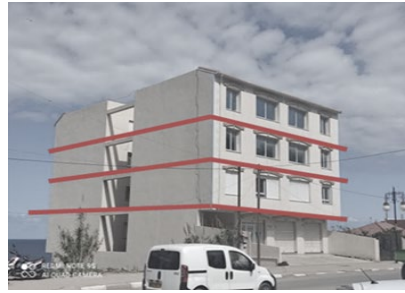
Figure 100 : Bâti en R+3 source : auteurs.
