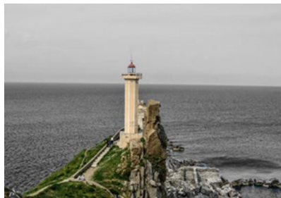
Figure 62 : phare Abdel Allah. Source : auteurs + traitement
