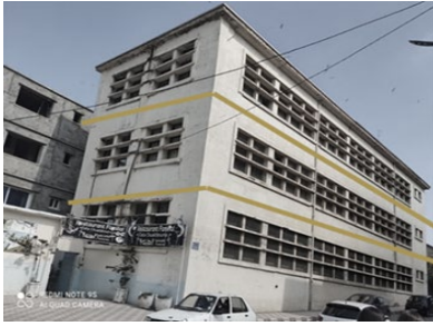
Figure 99 : Bâti en R+2. Source : Auteurs.
