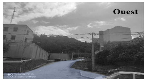
Figure 126 : Voie secondaire côté ouest. Source : Auteurs.
