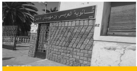
Figure 96 : Bâtis à usage autre que résidentiels. Source : auteurs.
