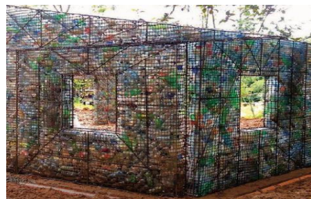
Figure.37: isolation en plastique récupéré. Source: PositiVR (2016).
