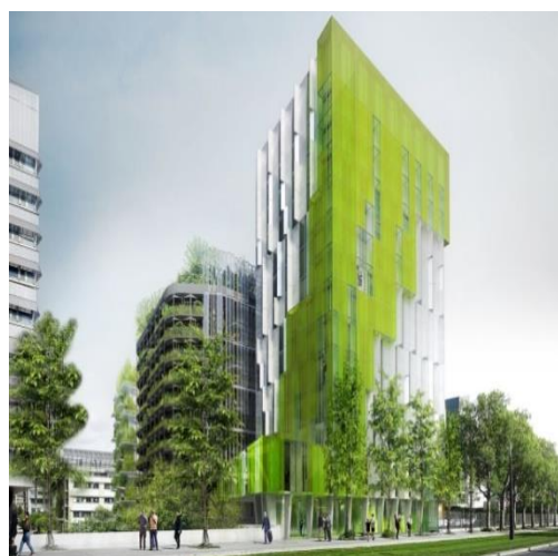
Figure.11: Projet «In-Vivo» avec une bio-façade de 900 m 2 .
