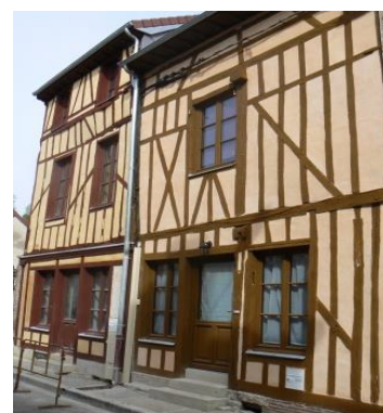
Figure.18: Les deux maisons après rénovation.
