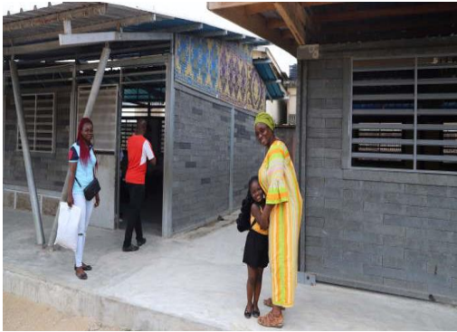
Figure.34: Ecoles ivoiriennes construite en plastique recyclé. Source : Le Monde Afrique (2019).
