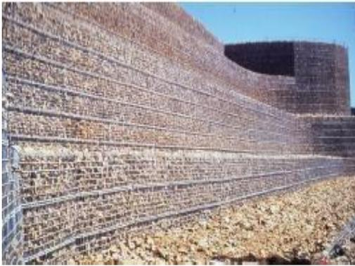
Fig. I. 1. Mur gabion métallique.
