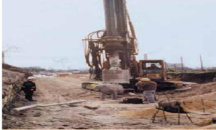
*Fig. II.51. Forage et mise en place des profilés métalliques.*
