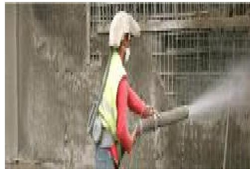
Fig. II. 59. Exécution de la couche de béton projeté.
