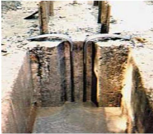
Fig. II.29. Joint semi circulaire.
