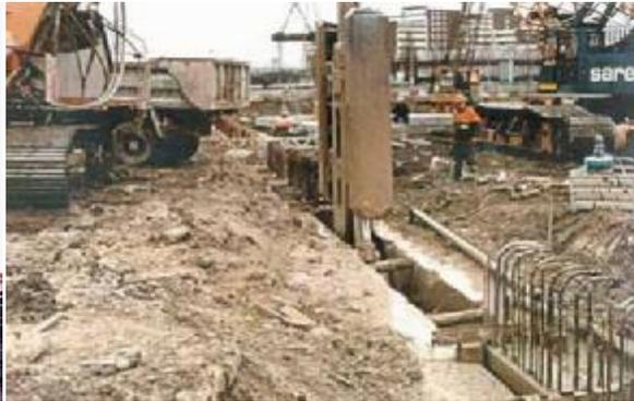
Fig. II.26. L'excavation de la tranchée.
