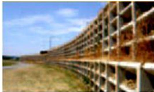
Fig. I.5. Vue finale d'un mur caisson.
