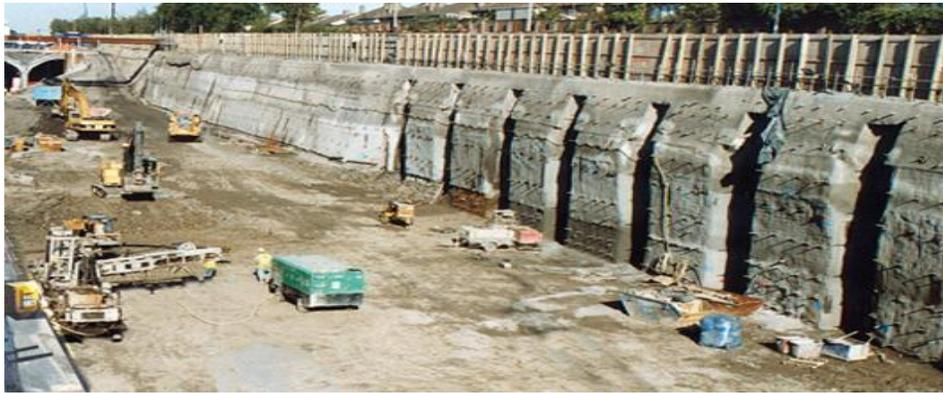
Fig. II. 63. Photo d'une Paroi clouée.
