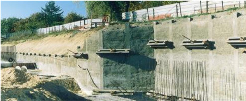
Fig. III. 1. Mur en tirant d'ancrage.
