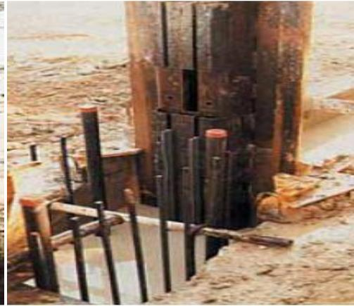
Fig. II.30 Ferrailage et coulage d'un joint.
