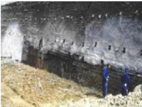
Fig. II. 58. Exécution de la première nappe d'armature.
