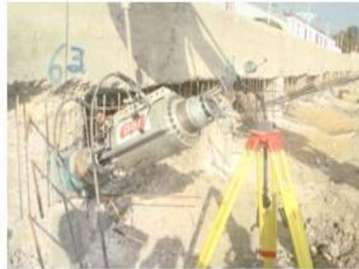
fig.III. 13. Mise en place de vérin
