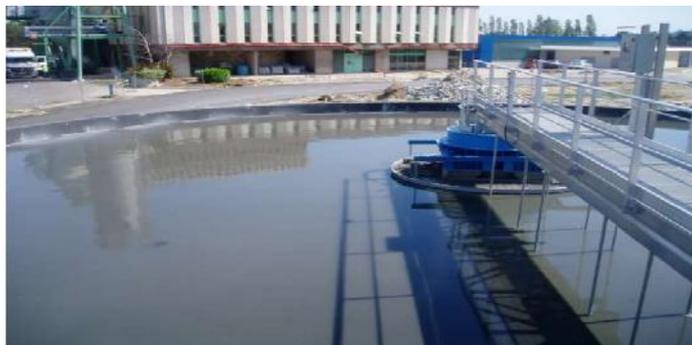
Figure I-2 : Nouveaux décanteurs circulaires raclés [65].
