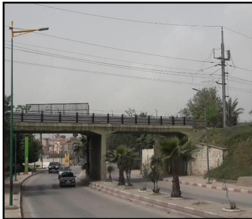
Fig21 : photo du pont Source : auteurs
