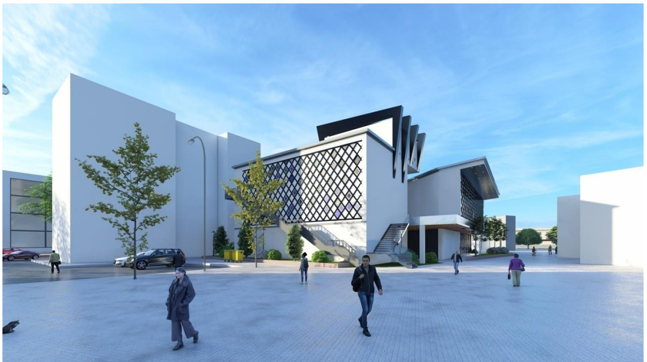
Vue sur la façade sud du projet
