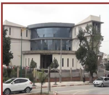
Fig39: musée régional de Tizi-Ouzou ( en chantier)
