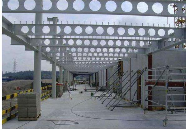
Figure VI.14 : Exemple de poutre alvéolaire employée au sein du projet.
