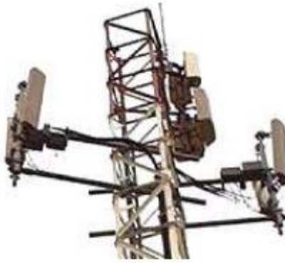
Site bisectorisé avec utilisation de la diversité spatiale et 4 antennes-panneaux directionnelles
