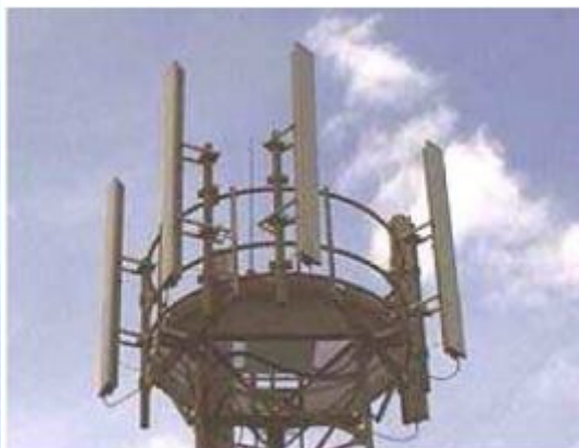
Site trisectorisé avec utilisation de diversité spatiale et 6 antennes-panneaux directionnelles
