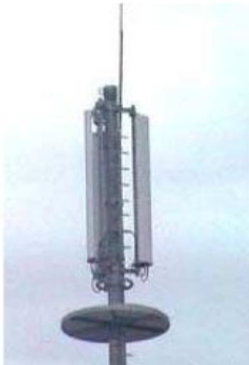
Site trisectorisé avec utilisation de diversité spatiale et 6 antennes-panneaux directionnelles
