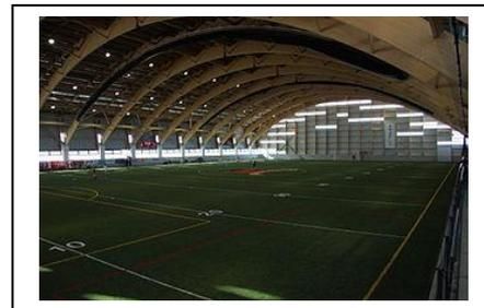
Figure 154: La toiture courbe à ossature de bois lamellé-collé
