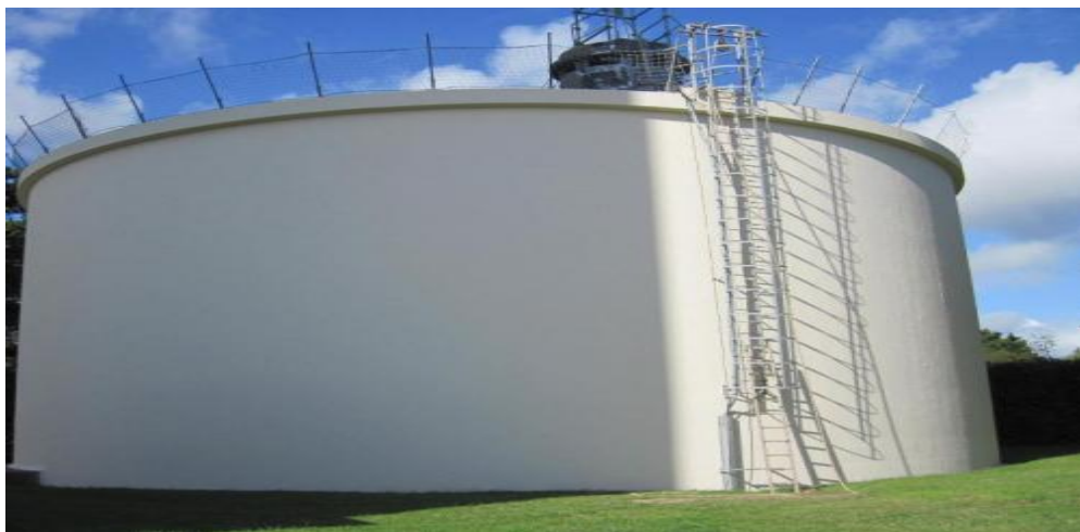
Figure III.4. Exemple du réservoir sur le sol.
