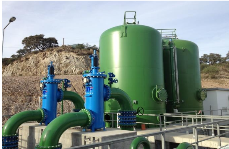
Figure VI.4. Réservoir anti-Bélier
