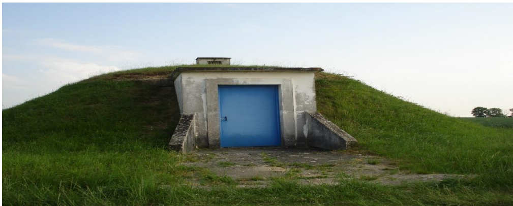
Figure III.2. : Exemple du réservoir enterré.
