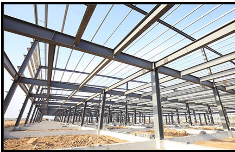
Figure 1: structure à ossature métallique Source : http://www.raymetal.com/structure-metallique-joliette-berthierville-lassomption.html
