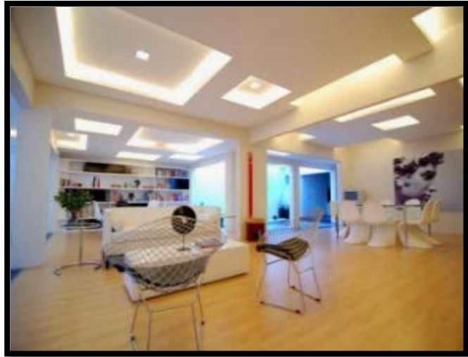
Figure : un faux plafond en plâtre .4
