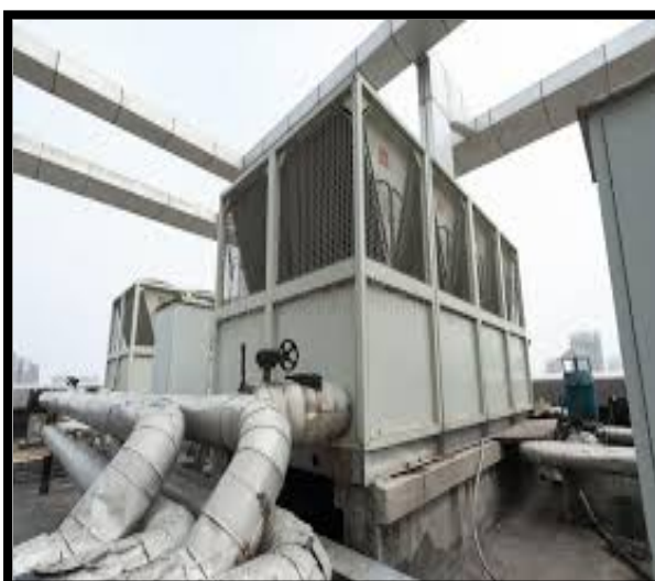
Figure : une unité de climatisation. Source : http://www.energieplus-lesite.be .
