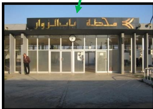
Sud par chemin de fer
