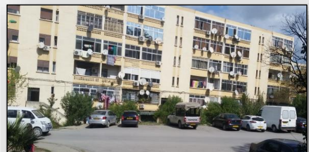
Figure 12 : La cité 5 juillet Source : auteur
