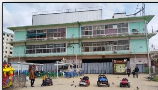
Figure 37 : La bâtisse de la gare.
