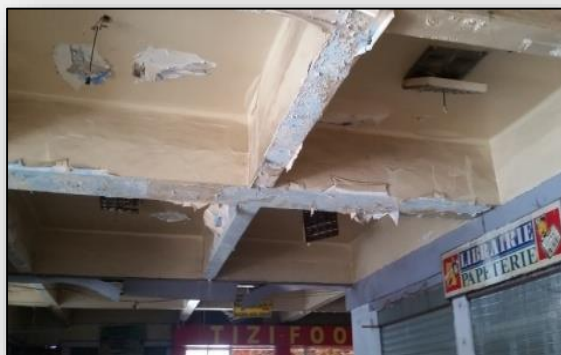
Figure 43 : état de la structure Source: auteur
