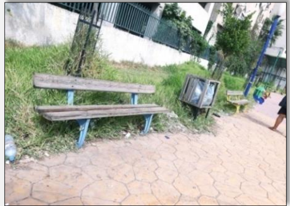
Figure 55 : état du mobilier source: auteur
