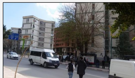
Figure 21 : Rupture de la façade de la cité 20 Aout Source: Auteur
