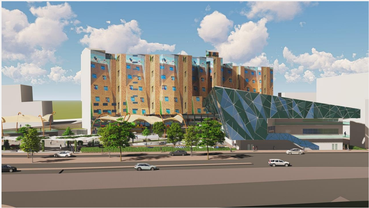
Façade principale (Sud)
