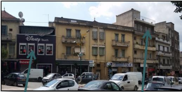
Rénovation de la façade
