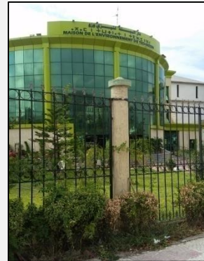
Figure 16 : Façade du Siège de la DLEP. Source: auteur
