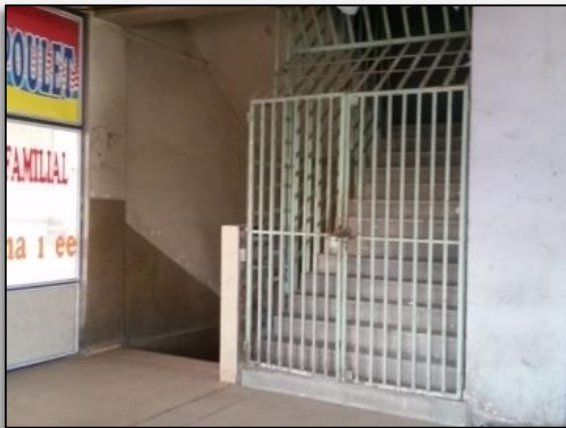
Figure 47 : La cage d'escaliers Source: auteur
