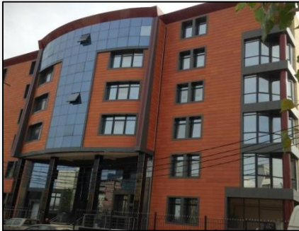
Figure 15 : Façade de la direction d'environnement et du musée régional. Source: auteur
