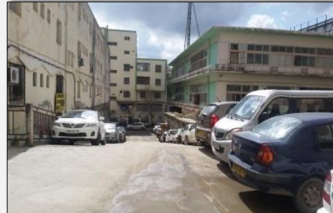
Figure 50 : la façade Est donnant sur l'EPLF. Source: auteur
