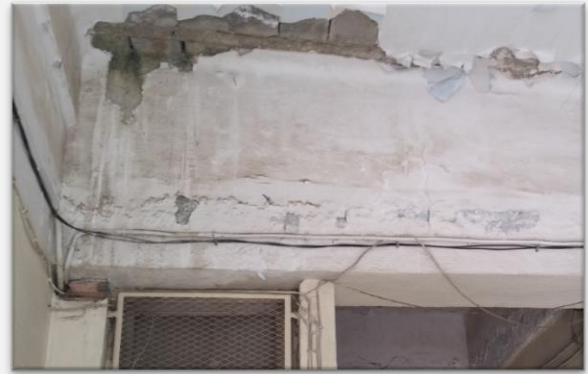
Figure 132 : Plancher corps creux. Source : Auteur.
