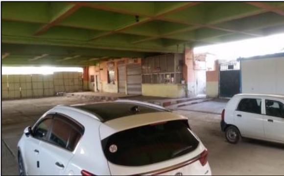
Figure 45 : vue sur le RDC dégagé. Source: auteur.
