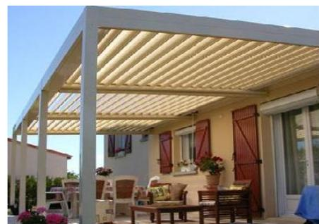
Les protections horizontales projettent une ombre verticale sur les parois devant lesquelles elles se déploient. Plus le soleil est haut dans le ciel, plus l'ombre couvrira une surface importante de la façade. On les retrouvera donc idéalement sur les orientations sud. Confectionner en bois avec une protection supplémentaire pour éviter les moisissures et la dégradation rapide. Ils serviront aussi pour support des plantes grimpantes assurant un ombrage en été.
