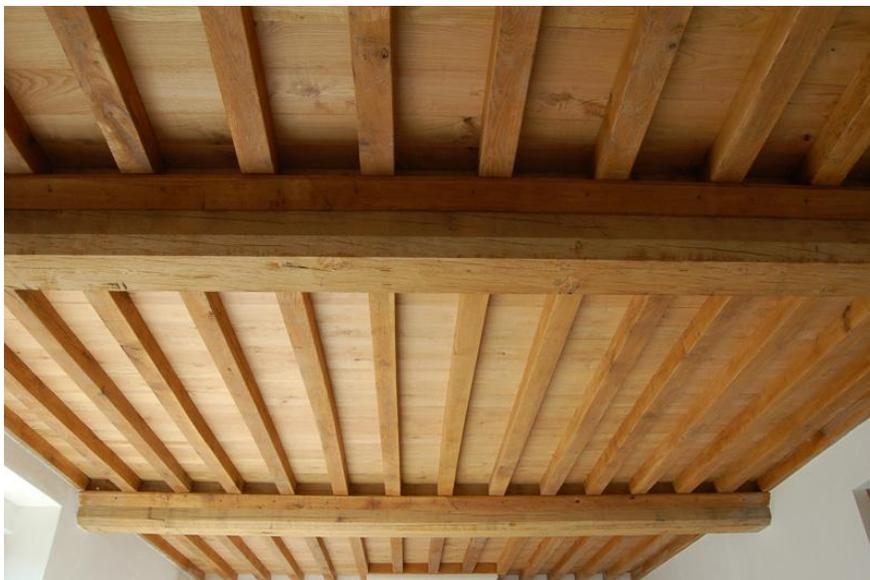
**Figure 72 :vue sur un plancher bois-béton**
