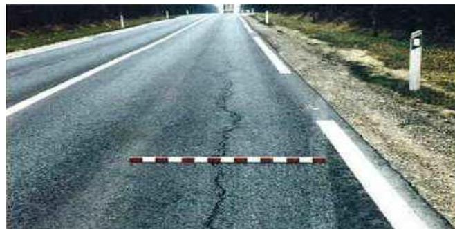
Figure I.13 : Fissures longitudinales.
