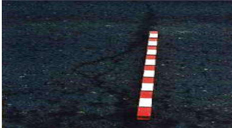
Figure I.12 : Fissures transversales.
