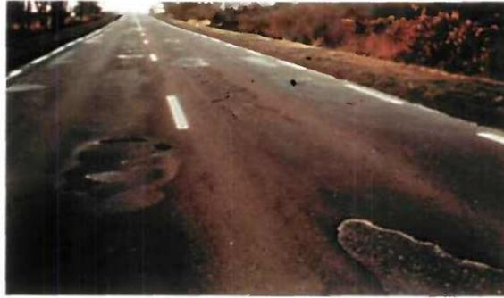
Figure I.16 Pelade sur enrobé de faible épaisseur
