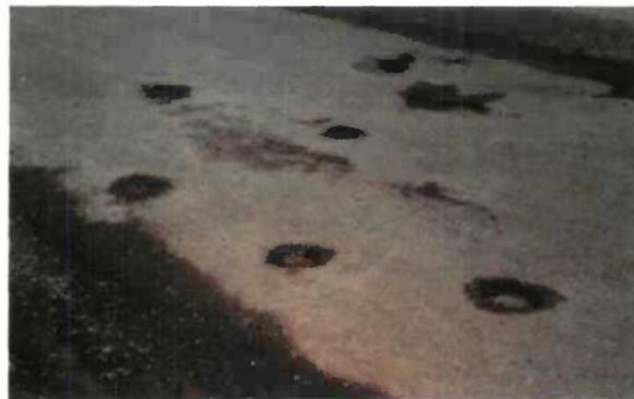
Figure I.15 : Nid de poule nécessitant un bouchage d'urgence.
