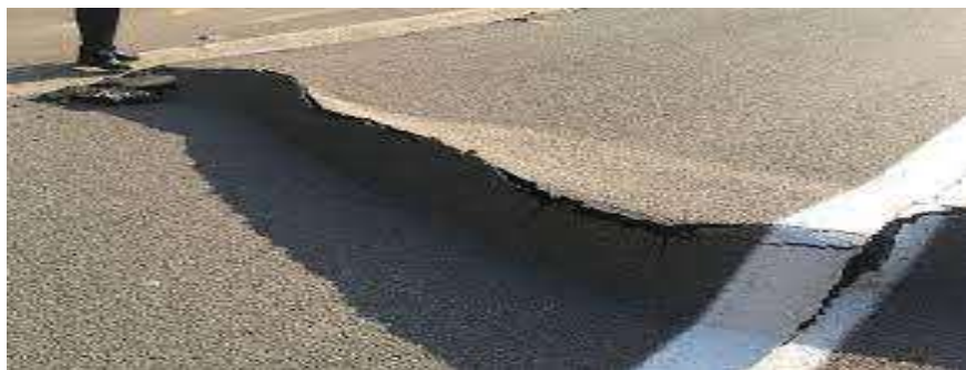
Figure I.15: soulèvement différentiel (MDCS, Québec, 2002)
