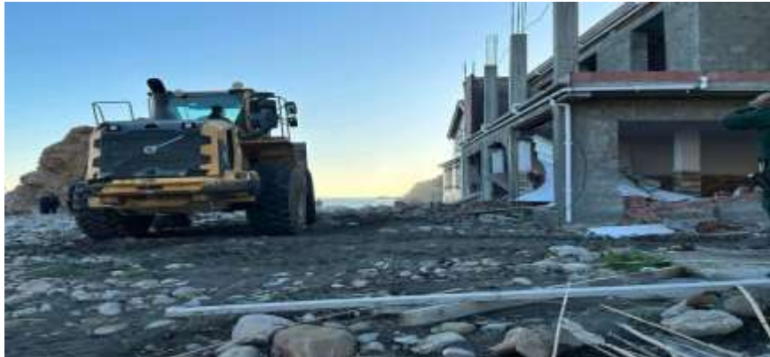
Figure II.2 : Démolition de constructions illicites à Bejaïa
