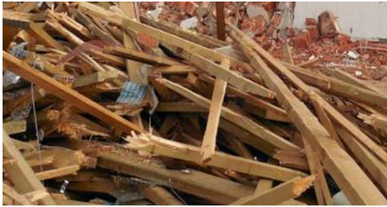
Figure II.4 : restes des coffrages en bois (Guide Bâtiment Durable, Bruxelles 2017).
