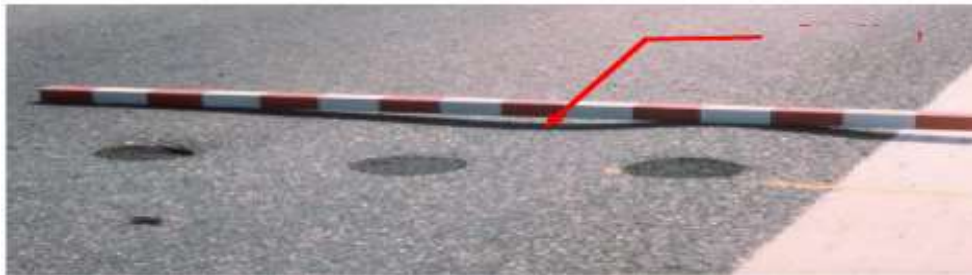
Figure I.12: L'orniérage à faible rayon (ZEMMIRI. A.A 2008)
