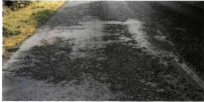
Figure I.21 : Plumage généralisé (Slideshare, 2013)
