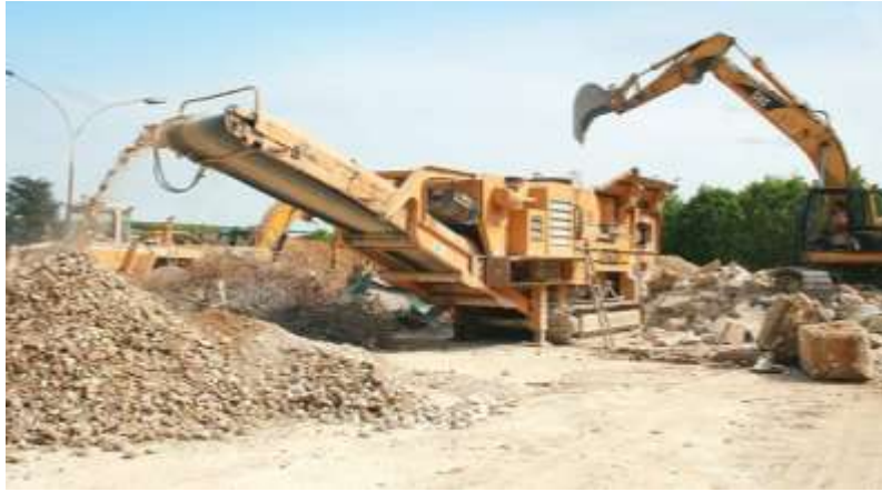
Figure II.10 : Concassage mobile, valorisation déchets inertes.
