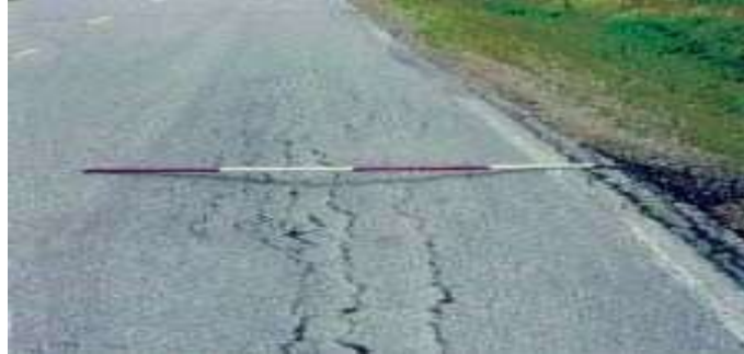
Figure I.14: L'affaissement hors rive (flashe) (LCPC, 1998)
