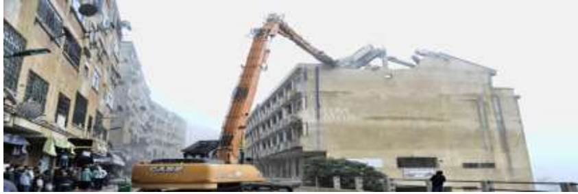
Figure II.1 : Opération de démolition de la ville de Ain El Hammam
