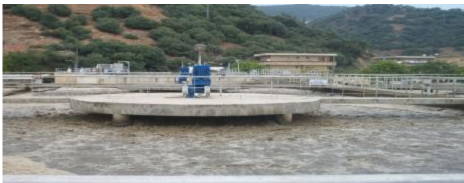
Figure07 : Le bassin des boues activées aérée de la station ONA.
