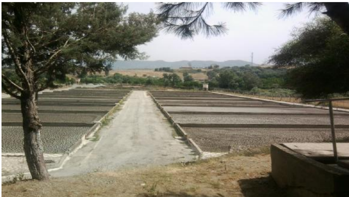
Figure 11 : Lits de séchage de la station ONA.
