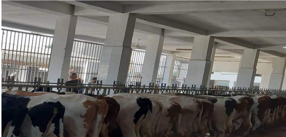
Figure 13 : Aération naturelle à l'intérieure d'un bâtiment d'élevage (originale 2022)
