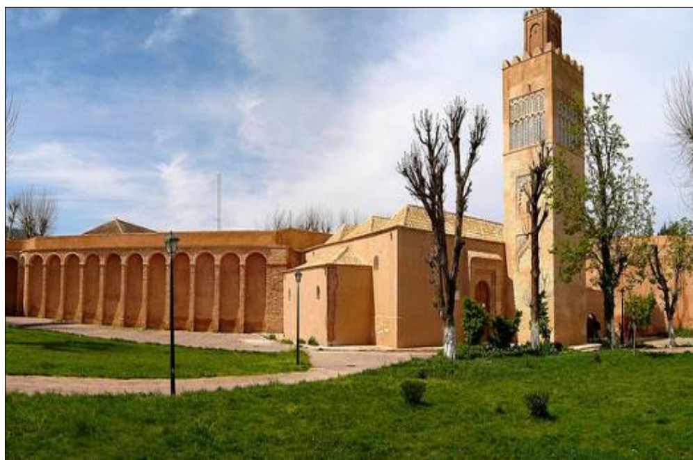
Photo 2.25 : vue sur la mosquée et rempart intérieur après la restauration
