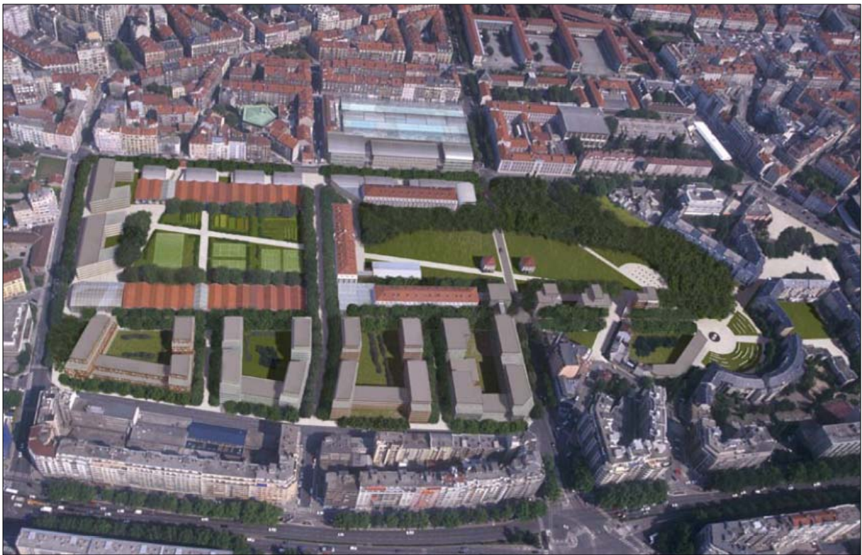
Figure 1.32. La caserne de Bonne à Grenoble, insérée dans un projet de développement de la ville, constitue aujourd'hui un nouveau quartier d'habitat.
