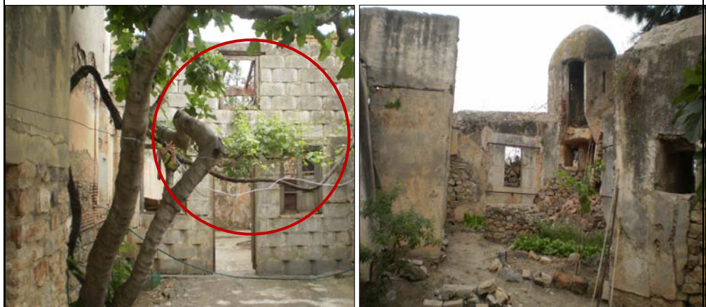
Photos 4.38 et 4.39 : vues intérieures sur le fort Clauzel.
