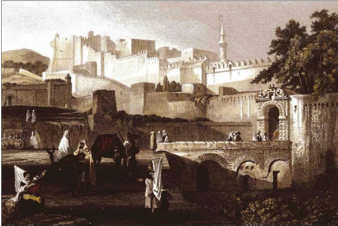
Figure 2.19 : Vue sur le rempart et Bab Azzoun. Alger
