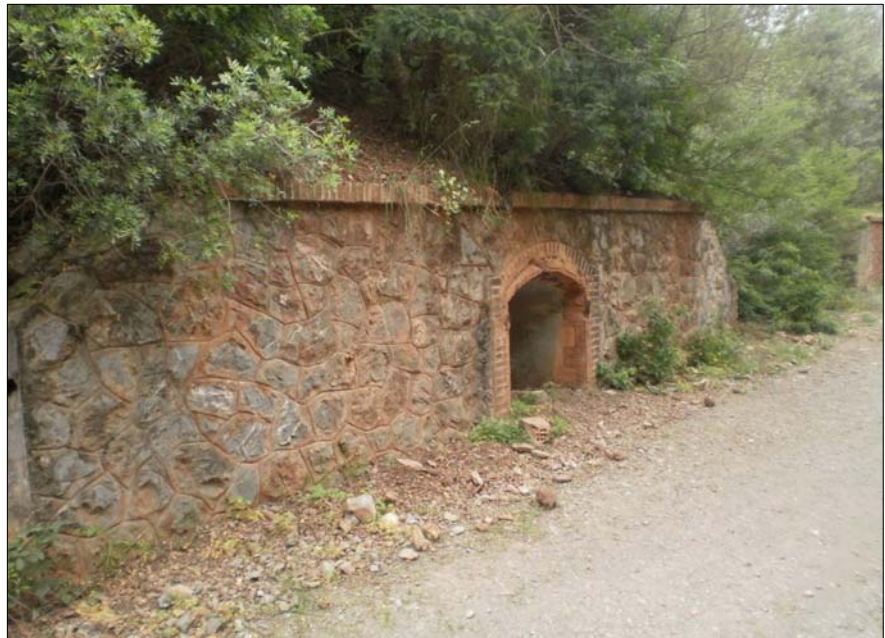
Photo 4.45 : vue sur une niche à munition
