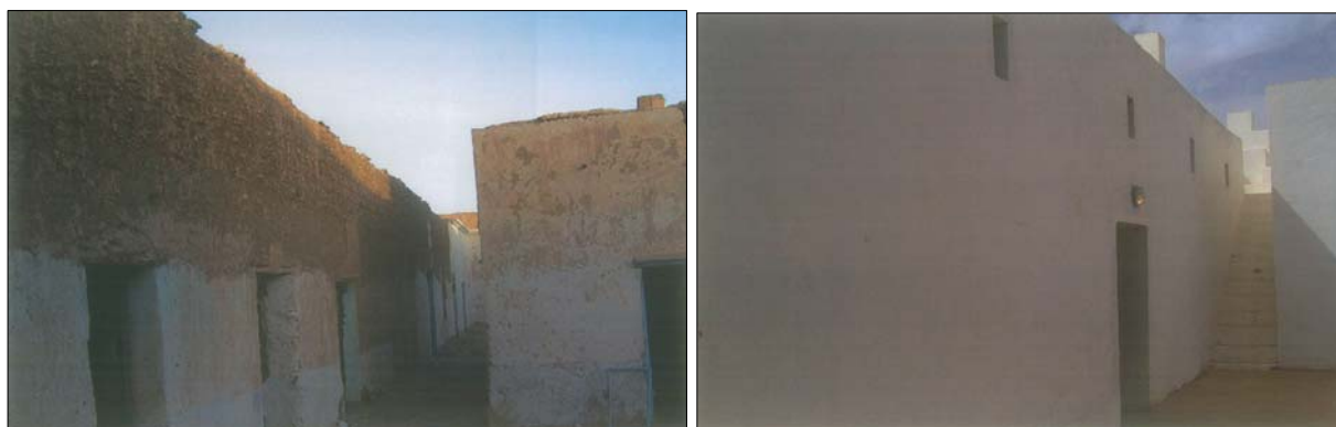
Photos 2.21 et 2.22 : vues sur les murs du fort avant et après la restauration
