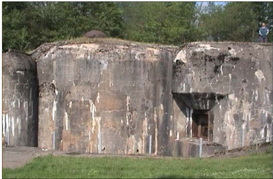
Figure 1.29 : Vue sur les blocs du fort de Maginot
