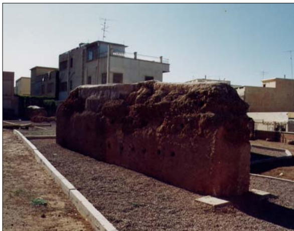
Photo 2.15: Restes des remparts. Tlemcen
