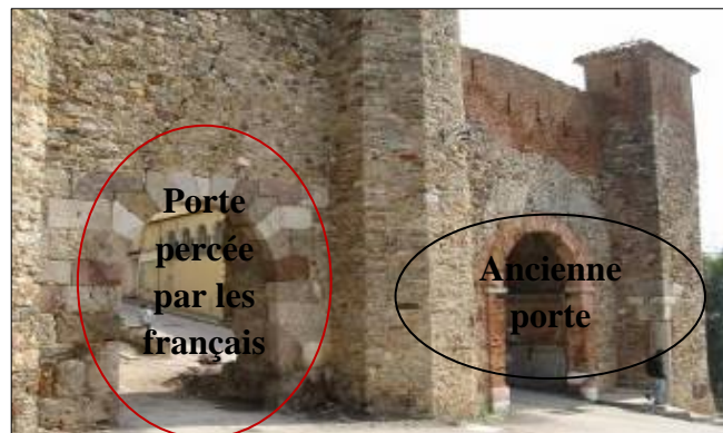
Photo 4.9 : Vue sur la porte Fouka, côté extérieur de la ville
