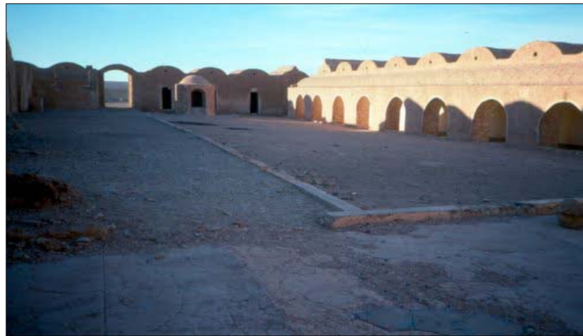
Photo 2.8 : vue à l'intérieur du fort Miribel
