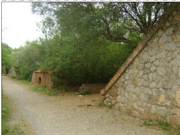
Photo 2.19 : Vue sur la batterie du centre. Bejaia
