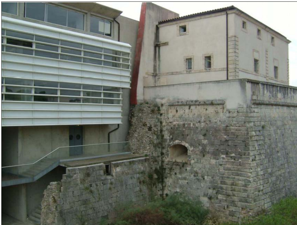
Figure 1.38 Vue sur la bibliothèque
