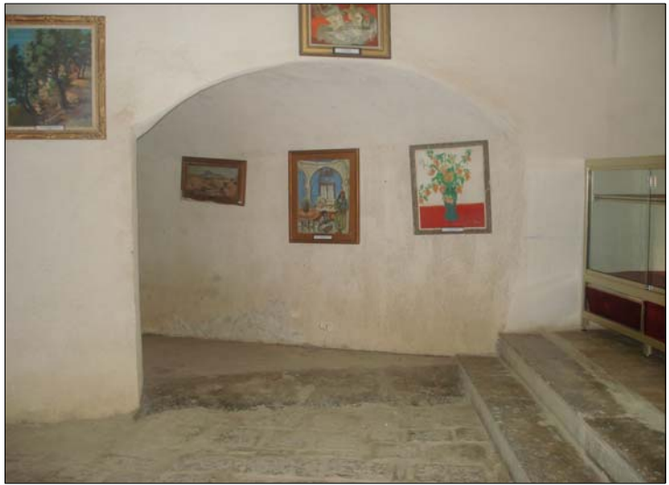
Photo 4.23 : Vue sur l'intérieur du fort après sa réhabilitation
