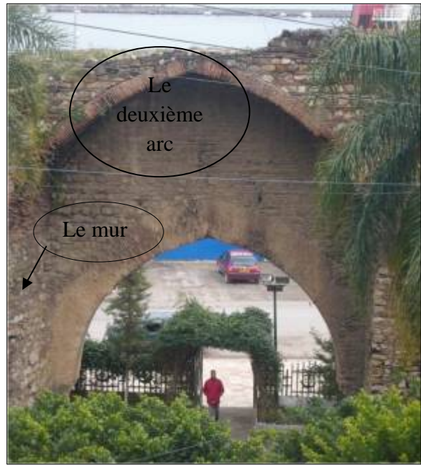
Photo 4.7 : Vue sur le 2 ème arc de la porte sarrasine
