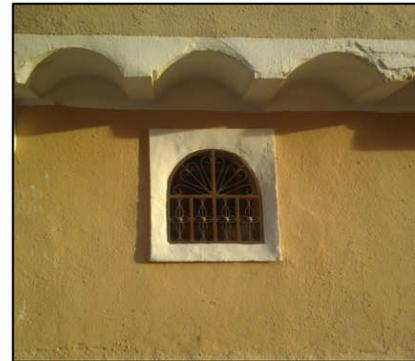
Figure I.7 : Articulation fenêtre-façade au moyen d'un encadrement blanc en sailli. (Source : photo prise par l'auteur au K'sar de Tafilelt, Ghardaia, le 24-05-2012)
