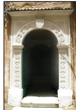
Figure II.28 : Porte d'entrée typique d'une maison à la Casbah d'Alger, surmontée d'un arc mené d'une agrafe et reposant sur deux pilastres. Le tout forme un chambranle aux motifs floraux, adossé à un panneau sculpté. (Source : [www.al-djazaier.com](http://www.al-djazaier.com))
