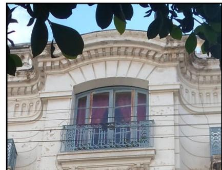
Figure II.12 : Appareillage au-dessus de la baie. Moulures soulignant la corniche et refends horizontaux strient la totalité de la façade. Immeuble N°14, Rue Ben M'hidi, Alger (Source : l'auteur, 2012).
