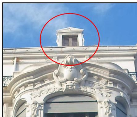
Figure III.42 : Lucarne surmonté d'un fronton triangulaire et encadré par un chambranle. Immeuble N°39 (Source : l'auteur, 2012).
