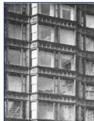
Figure I.18 : La fenêtre de Chicago (source : GYMPEL, 1996)
