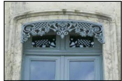
Figure II.35 : Lambrequin ou dentelle de fenêtre. (Source : [www. www.urba-nyon.ch](http://www.urba-nyon.ch))
