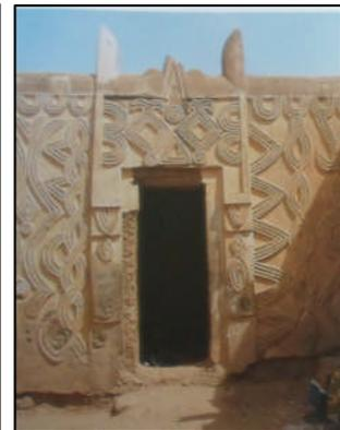
Figure II.24 : Porte d'entrée d'une maison haoussa, mise en exergue par un encadrement ornemental qui se détache de la façade (Source : LENCLOS, 2007).
