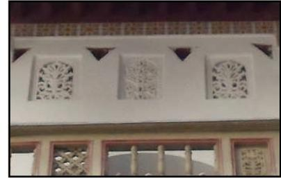
Figure II.29 : Trois petites ouvertures au dessus d'une porte masquée par des claustras de plâtre ouvragé. (Source : l'auteur, Bastion 23, Alger, 2012).
