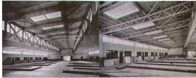
Fig4.46. Structure du bloc A de la Halle aux poissons ; Source. Revue Chantiers Nord-africains, juin 1939
