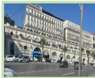
Fig2.14. Bâtiments du XIXème siècle. Source : Auteurs
