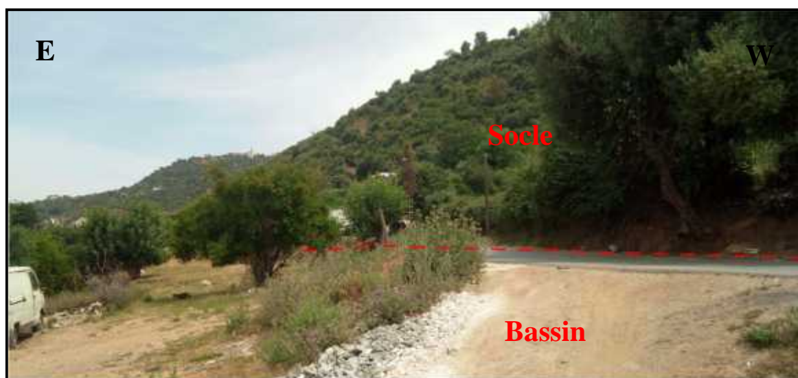
Figure IV. 07: Photo montrant une rupture de pente au niveau de Bouhinoun.
