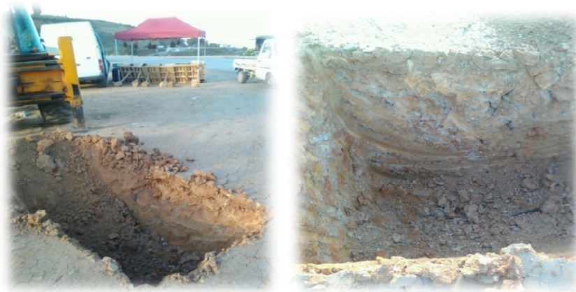
Figure 9: Photos du puits N°01
