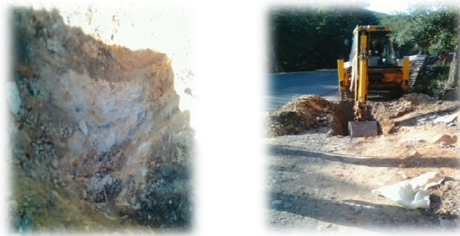
Figure 11 : Photos du puits N°03
