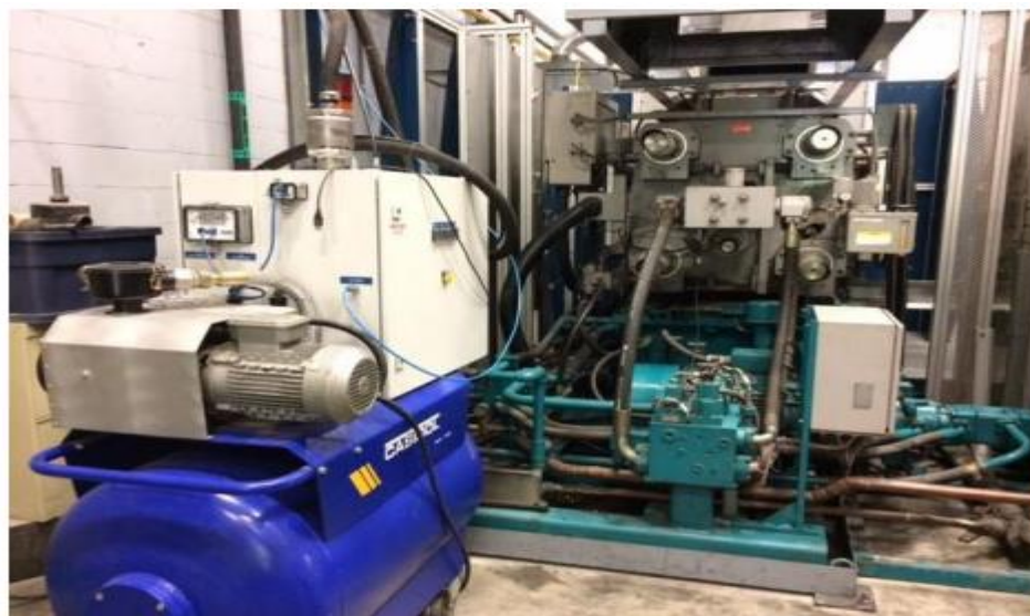
Figure 22 : Moteur et réservoir hydraulique à l'arrière de la presse
