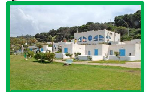
Réhabilitation du bordj turc
