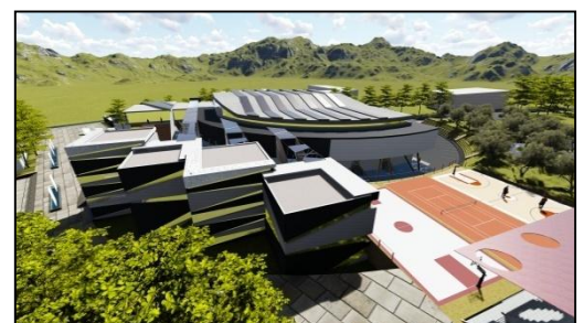
Figure 20 : Façade postérieur source : auteur
