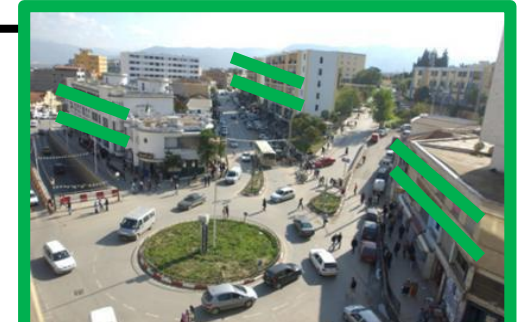
Rénovation des façades
