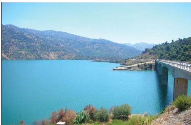
Figure 33 : le barrage de taksebt
