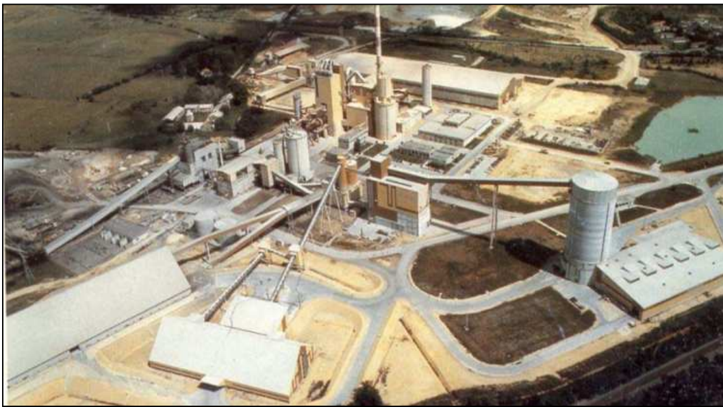
Figure I.1 : Vue aérienne d'une cimenterie.
