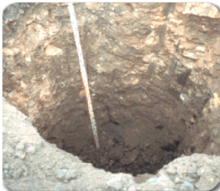
Figure II.8. Plot ballasté avant remblaiement type.
