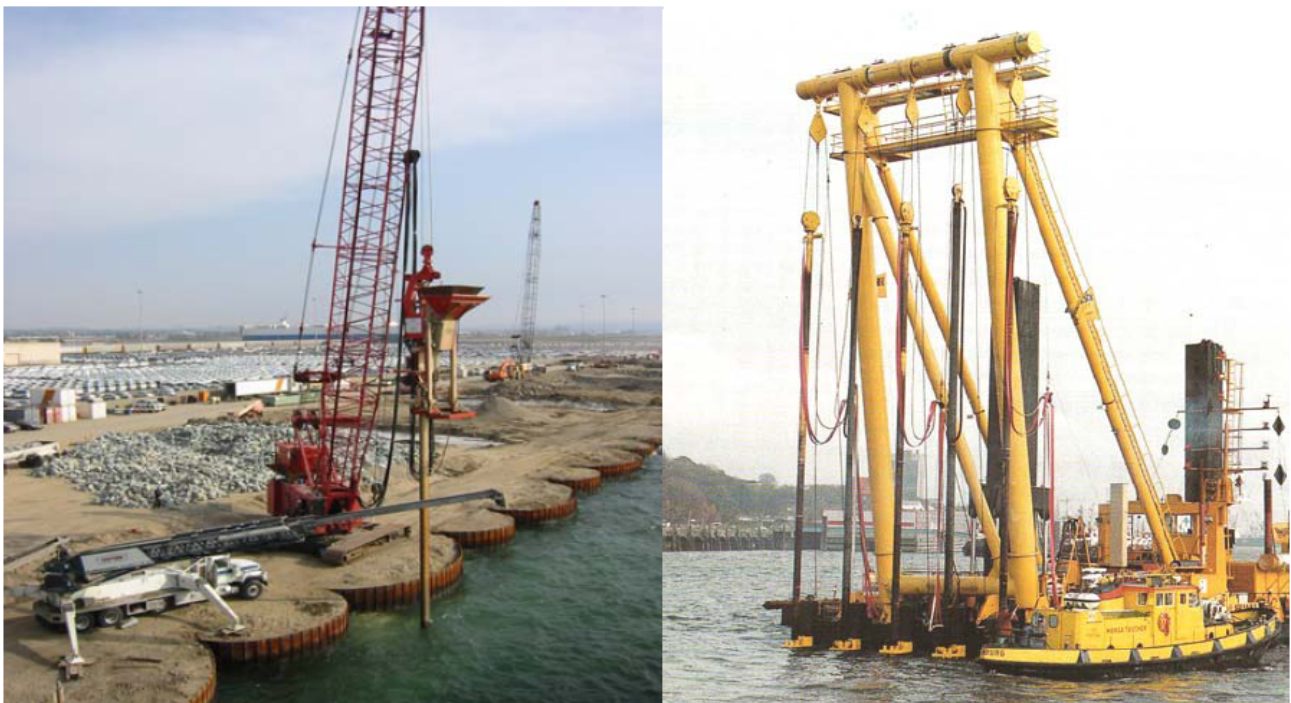
Figure II.10. Chantiers de colonnes ballastées dans la mer.
