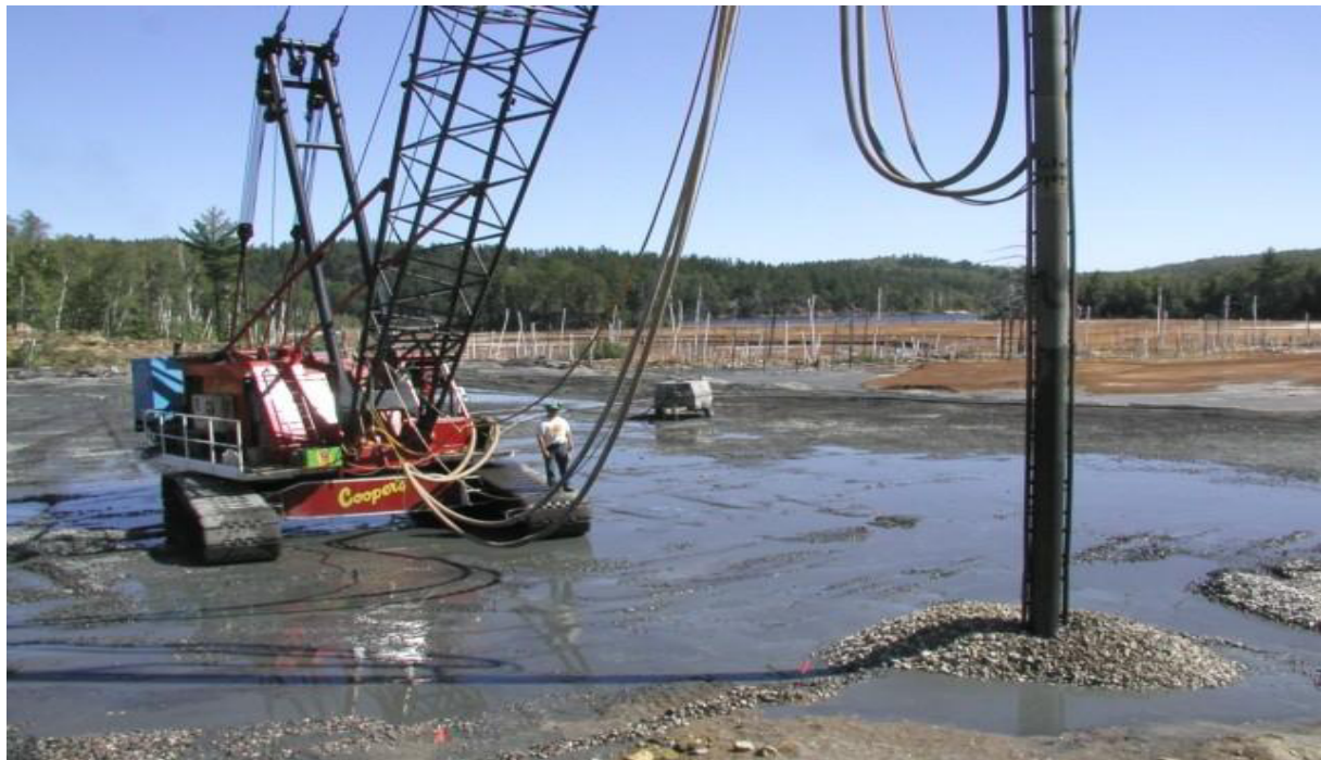
Figure I.6. Réalisation d'un chantier à la vibroflotation (Vibrateur électrique).
