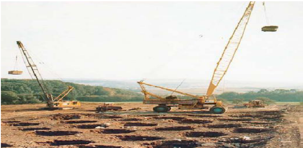
Figure I .4. Exemple de chantier de compactage dynamique.
