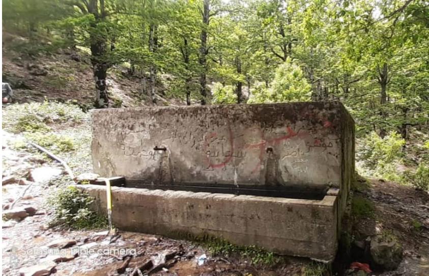
Figure 8. Point d'eau à Jijel (photo originale, 2023)
