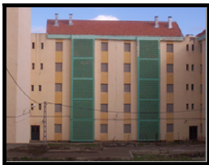
Figure 29 : Habitat collectif de la ZHUN source : auteur
