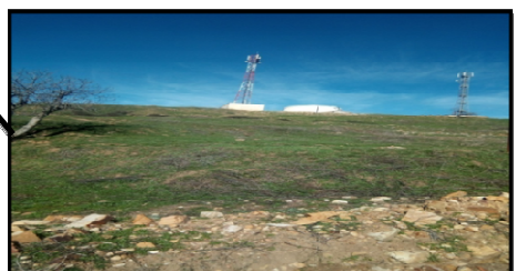
Figure 50 : pylône de relais pour téléphone mobile source : auteur
