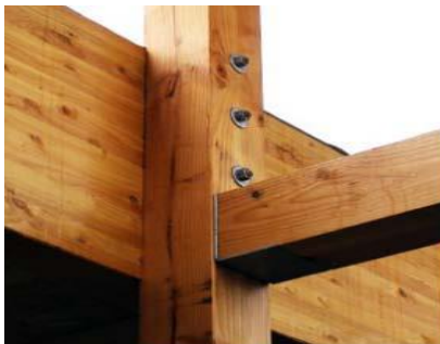
Figure 164 : détail d'assemblage poteau poutre
