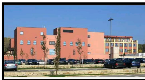
Figure 77:vue sur la façade sud source : http://de.mowikipedia.org
