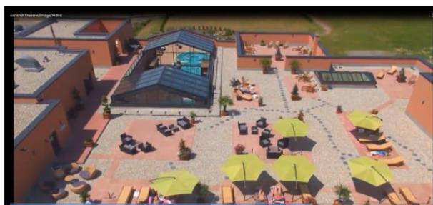
Figure 79 :vue sur le toit terrasse aménagée.
