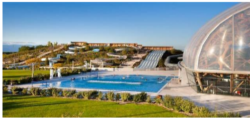
Figure 105 : vue sur la partie aquatique extérieure de vitam parc source : www.vitam parc.fr
