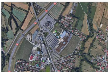
Figure 92 : La vue aérienne sur le projet source: google earth
