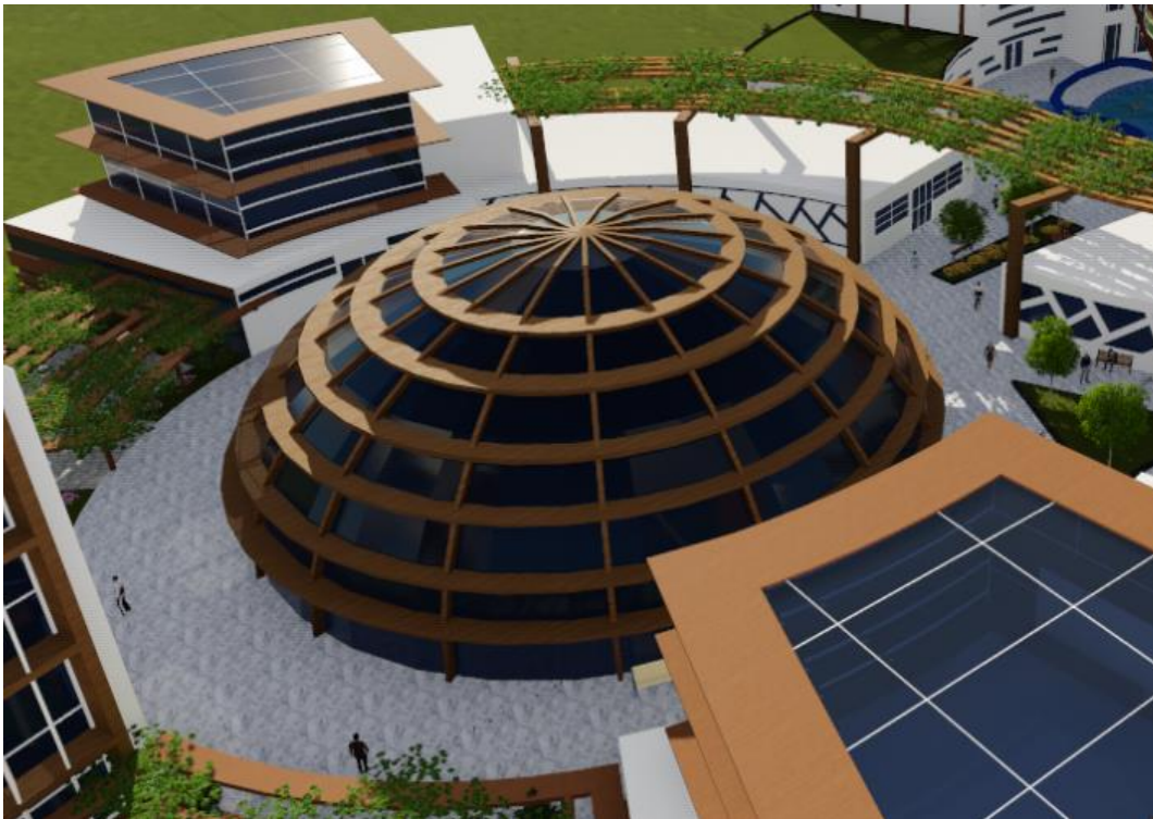
Figure139 : vue sur la cour centrale de l'entité soin
