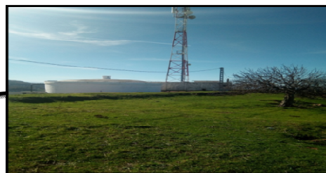
Figure 48 : un château d'eau source : auteur
