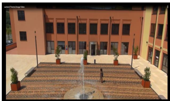
Figure 76 : vue sur la façade est.
