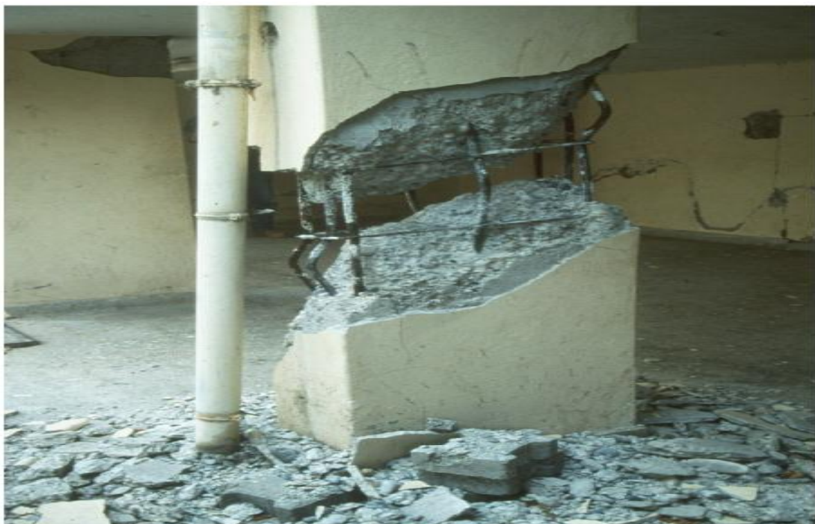
Figure I.7: Rupture pour mauvaise qualité des matériaux (Ceyhan 1998)
