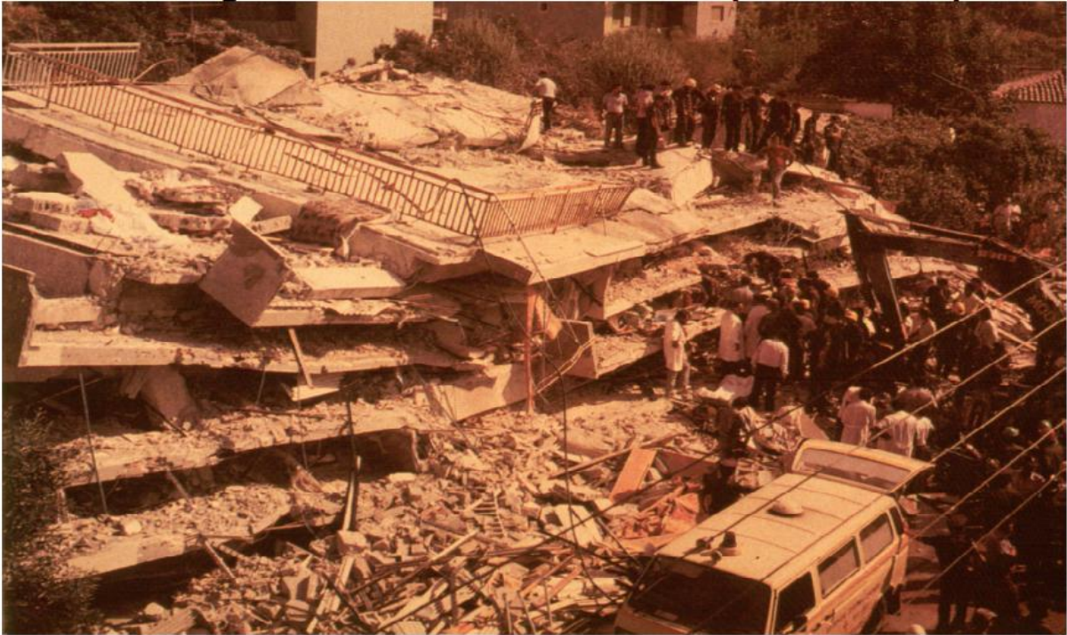
Figure I.4 : Effondrement total des constructions manquant de ductilité (Kalamata) [10]
