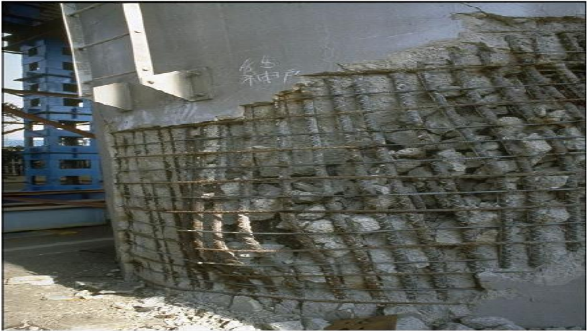
Figure I.12: Kobe béton armé confiné : comportement ductile [23]
