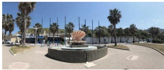
Les clôtures du port avant intervention , source : auteurs
