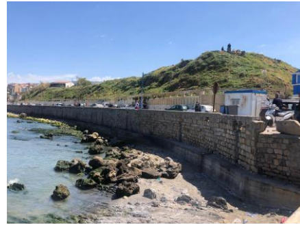
Figure III 119 Le front de mer avant intervention , source : auteurs
