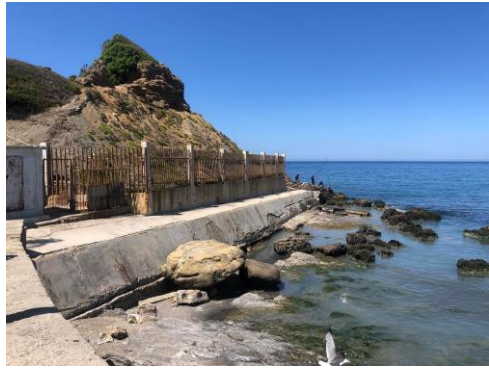
Figure III 113 Le front de mer avant intervention , source : auteurs
