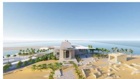
Figure IV 49 La façade principale du musée
