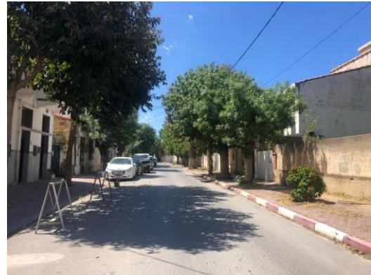
Figure III 62 La rue Ahmed Iften avant intervention , source : auteurs
