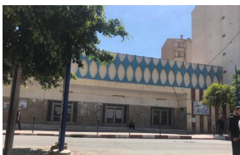
Figure III 40 le cinéma avant intervention , source : auteurs
