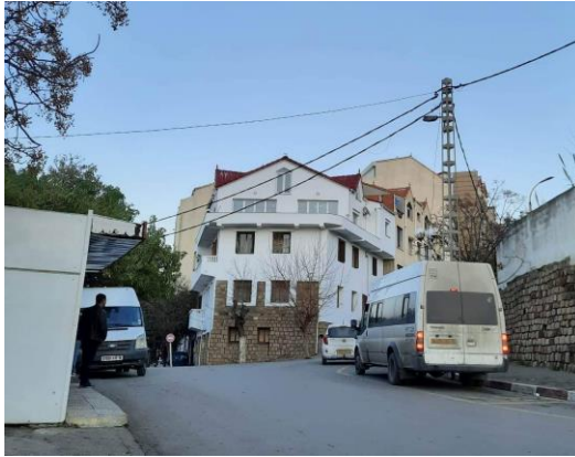
Figure III 61 La rue Ahmed Iften avant intervention , source : auteurs
