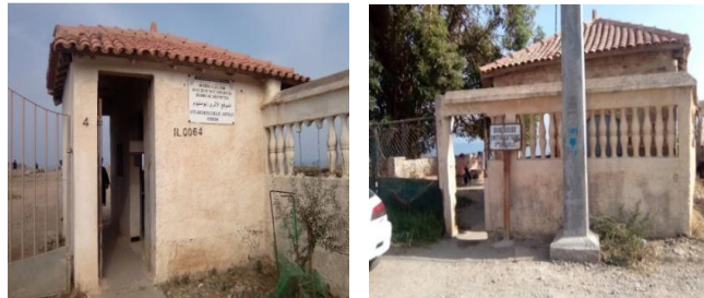
Figure II 103 Entrée non marqué, source : auteur
