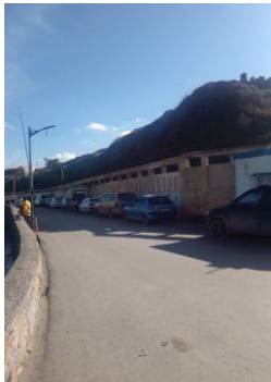
Figure III 126 Le front de mer avant intervention , source : auteurs
