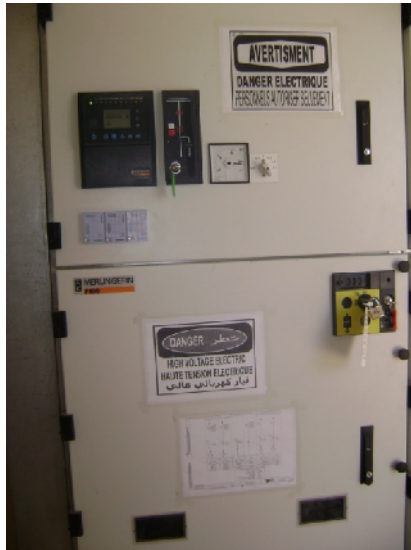
Figure I.9.a : UPS vue de l'extérieur
