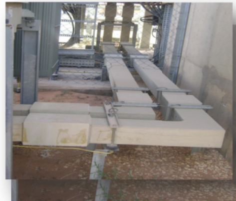
Figure I.7.b : Système d'isolation en bétobarre
